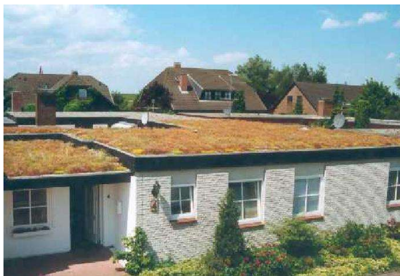
Figura 36 - Telhado Vivo Extensivo em Edificação Alemã.
