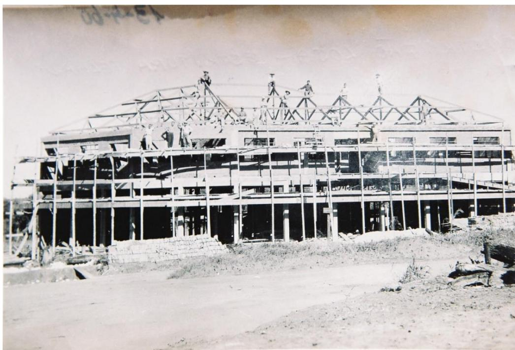
FIGURA 77 - MADEIRAMENTO DO TELHADO.
