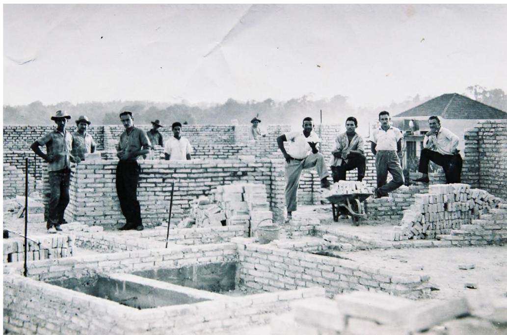
FIGURA 76 - ESTRUTURA DO PAVIMENTO SUPERIOR E A EXECUÇÃO DA ALVENARIA DOS DOIS PAVIMENTOS.
