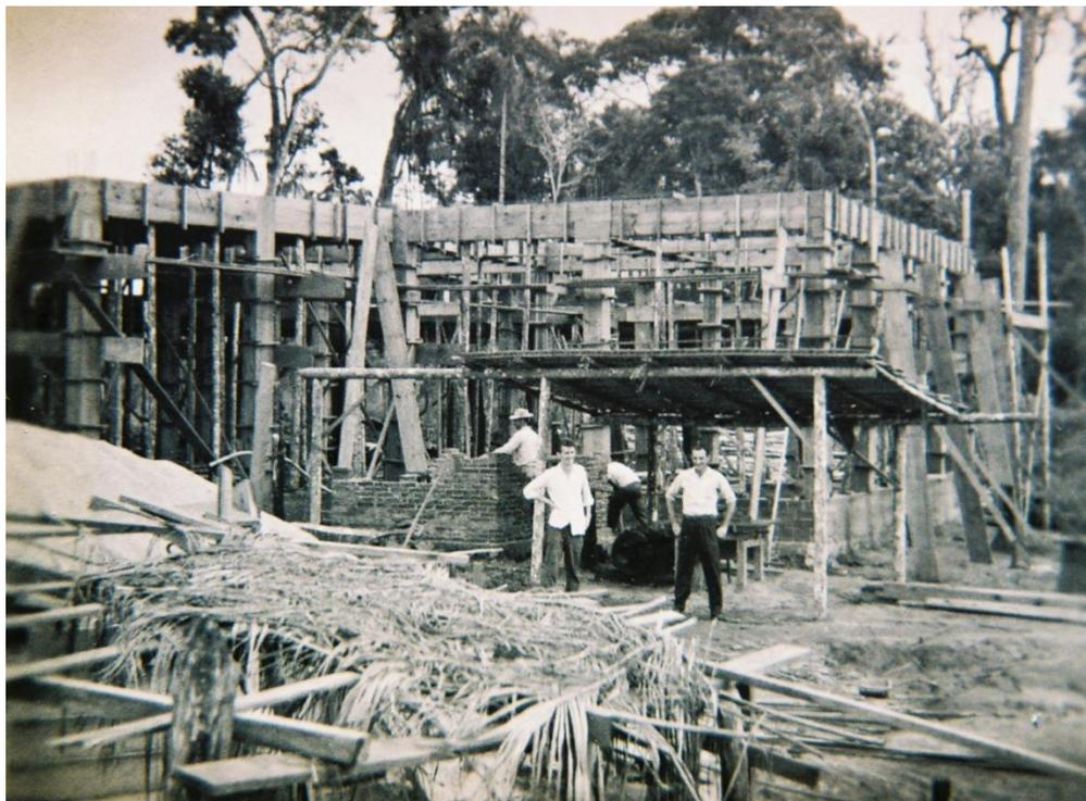
FIGURA 74 - ESTRUTURA DO PAVIMENTO TÉRREO.
