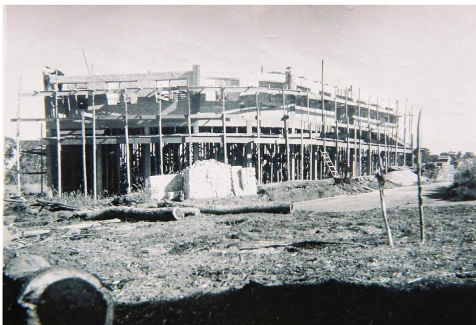
FIGURA 75 - ESTRUTURA DO PAVIMENTO SUPERIOR E A EXECUÇÃO DA ALVENARIA DOS DOIS PAVIMENTOS.
