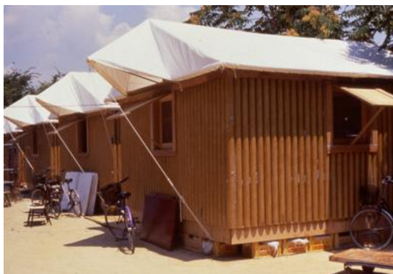
FIGURA 3.16 – Exterior de uma Paper Log House em Kobe, no Japão. (FONTE: Shigeru Ban Architects, 2011).
