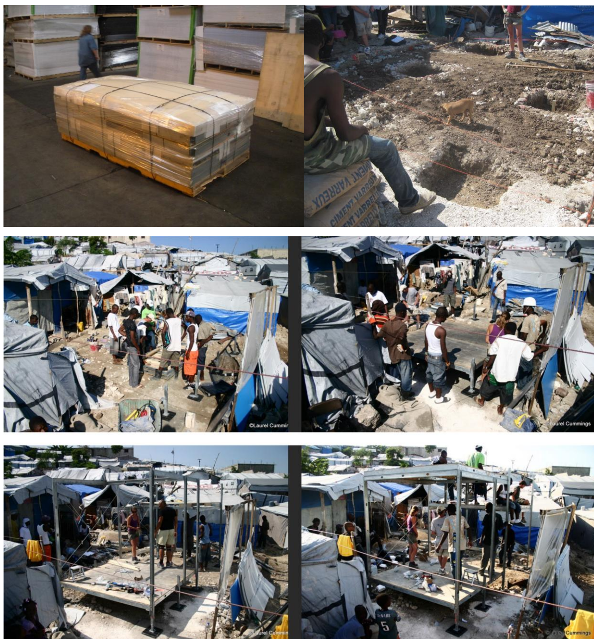
FIGURA 3.23 – Processo de montagem de uma unidade de T-Shell 2. (FONTE: UBERSHELTER, 2011).
