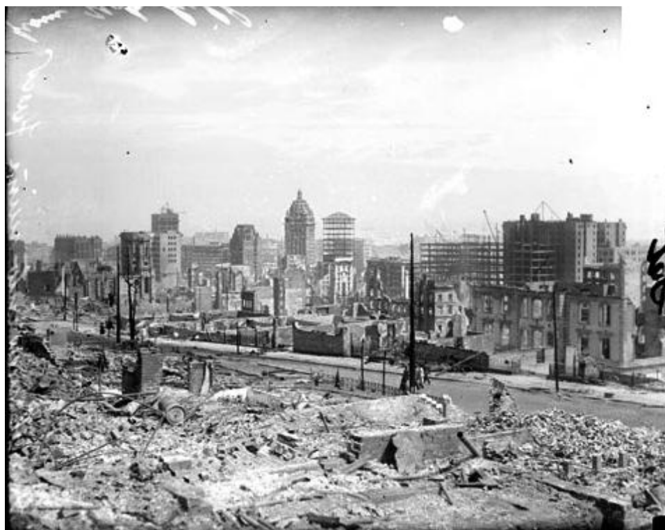
FIGURA 2.3 – Destruição do terremoto de São Francisco, em 1906. (FONTE: American Memory, 2011).
