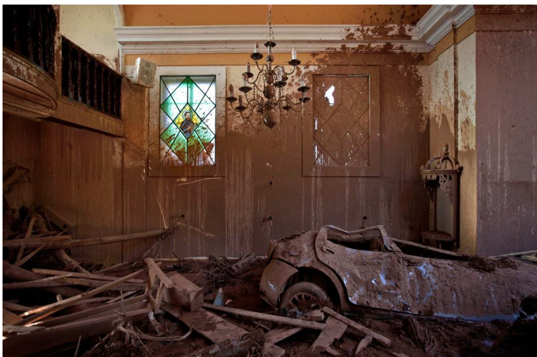
FIGURA 4.6 – Carro arrastado para dentro de uma igreja em Nova Friburgo, RJ, em 2011 (FONTE: BIG PICTURES, 2011).
