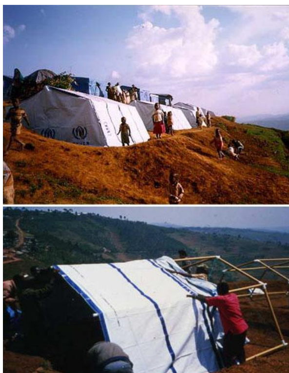
FIGURA 3.15 – Aplicação dos tubos de papel em tendas emergenciais, em Ruanda.
