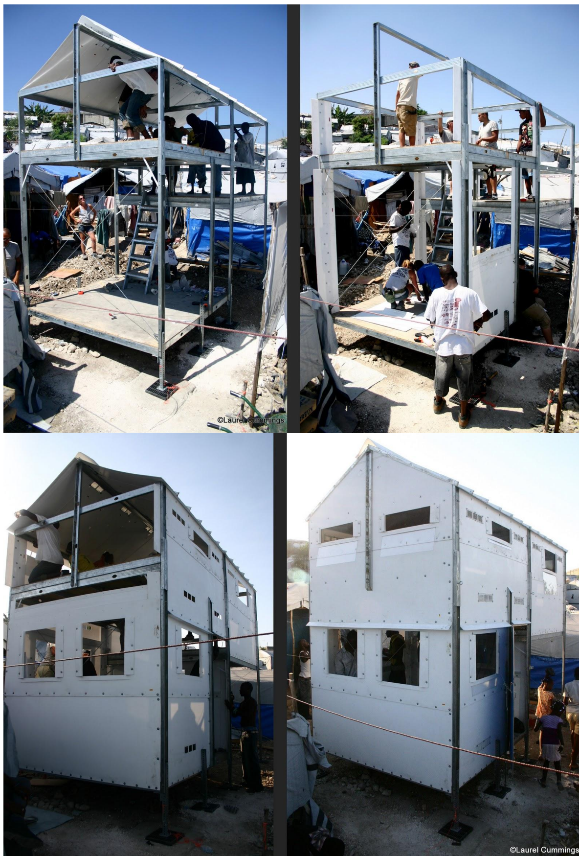
FIGURA 3.24 – Finalização do processo de montagem de uma unidade de T-Shell 2. (FONTE: UBERSHELTER, 2011).
