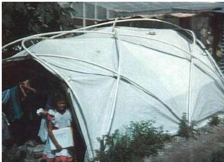
FIGURA 3.5 – Estrutura tensionada semelhante a barracas de camping (FONTE: ANDERS, 2002).
