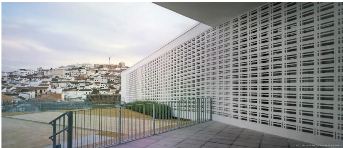
FIGURA 33 – REVESTIMENTO EXTERNO E BRISES DE CONCRETO
