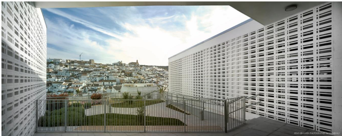
FIGURA 31 – ACESSO COM RAMPAS E GUARDA CORPO
