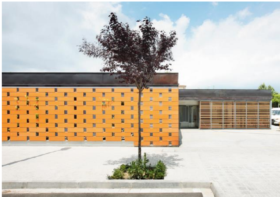
FIGURA 8 – PATIO DE ACESSO
