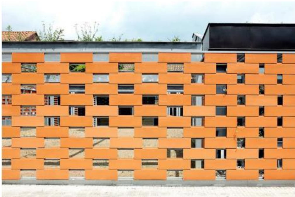
FIGURA 15 – MURO RELAÇÃO INTERIOR COM O EXTERIOR
