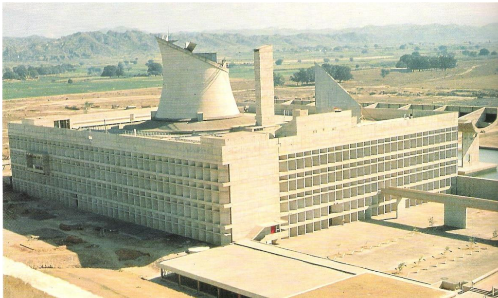
47 Foto do Parlamento já edificado
