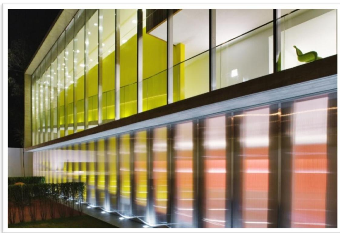
FIGURA 16 – Fachada frontal, vedação em vidro e policarbonato no pavimento térreo
