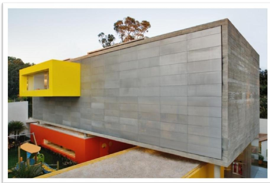
FIGURA 19 – Fachada com chapas perfuradas, opacas durante o dia.
