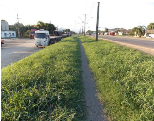
Figura 39: Trecho sem manutenção.
