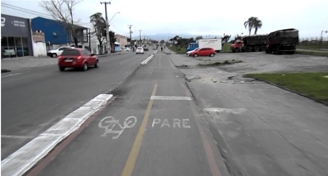
Figura 56: Sinalização horizontal de PARE voltada ao ciclista na Rua Domingos Peneda.
