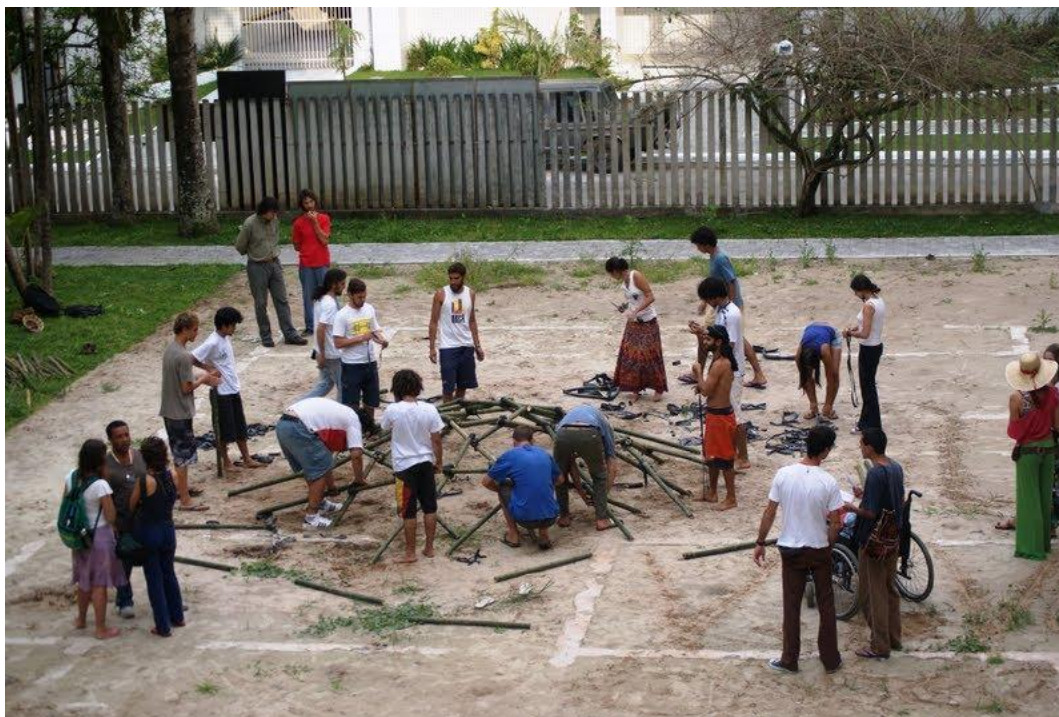
Figura 1: Oficina de construção de estrutura geodésica.
