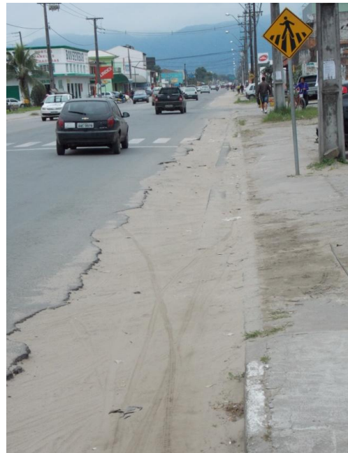
Figura 71: Obras de água e esgoto.
