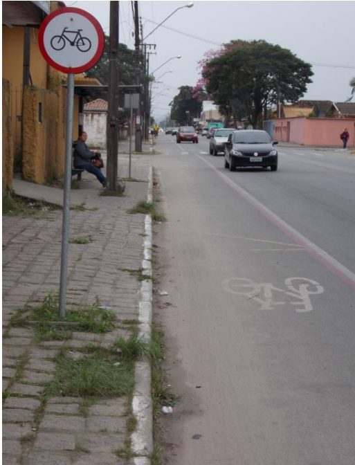
Figura 76: Sinalização e Pavimentação do trecho 3.
