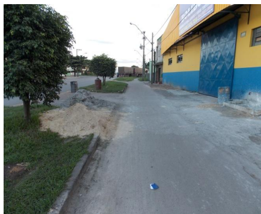
Figura 43: Materiais de construção na ciclovia.
