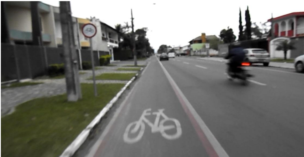
Figura 67: Pavimentação nova e sinalização horizontal e vertical da ciclofaixa da Rua Manoel Corrêa.
