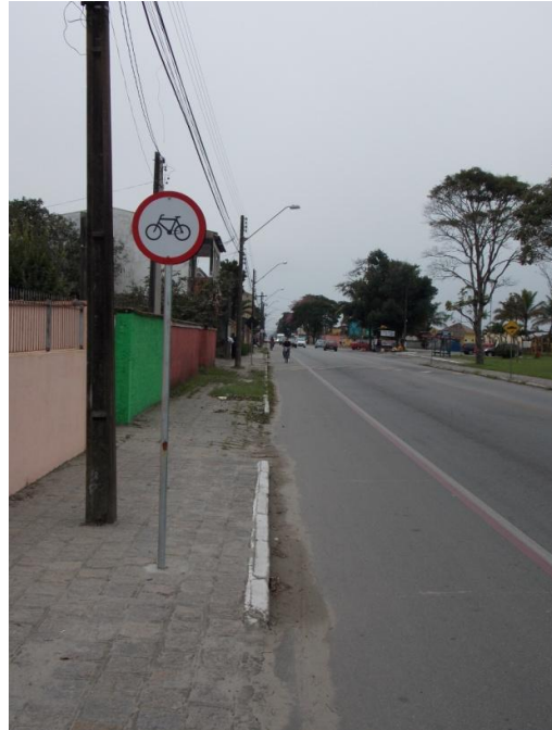
Figura 77: Sinalização e Pavimentação do trecho 3.
