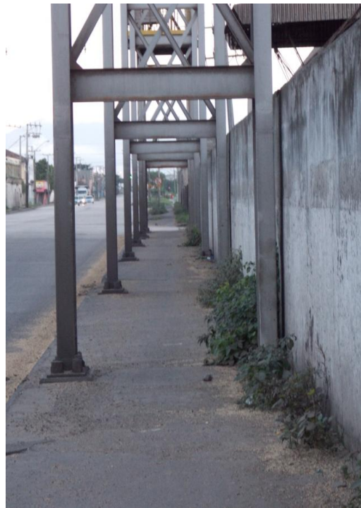
Figura 45: Ciclovia passando entre as instalações do equipamento.
