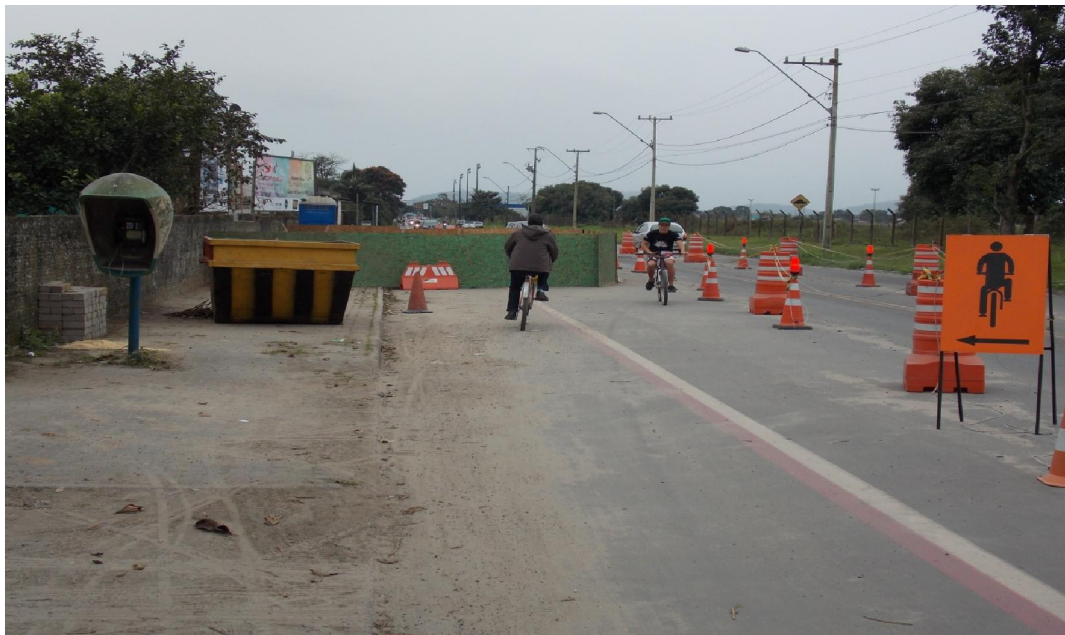
Figura 74: Obras na Avenida Bento Munhoz da Rocha Neto.
