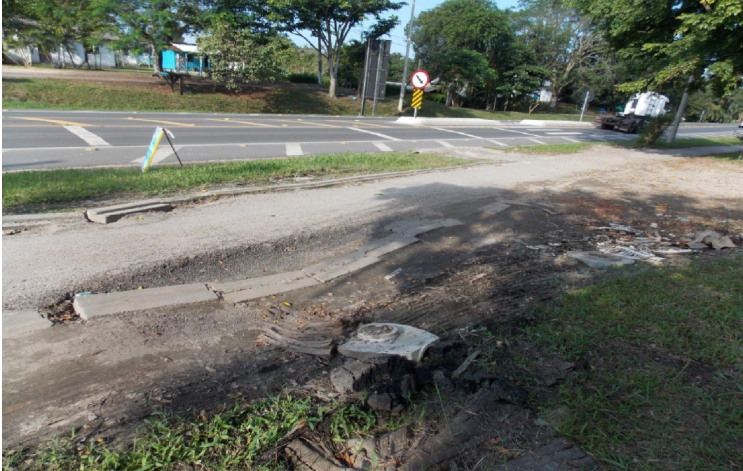
Figura 26: Ponto de manobra de veículos pesados sobre a ciclovia.
