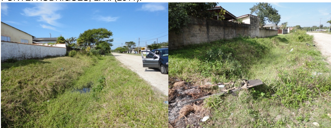
ESGOTO A CÉU ABERTO. FONTE: RODRIGUES, L. A. (2011).
