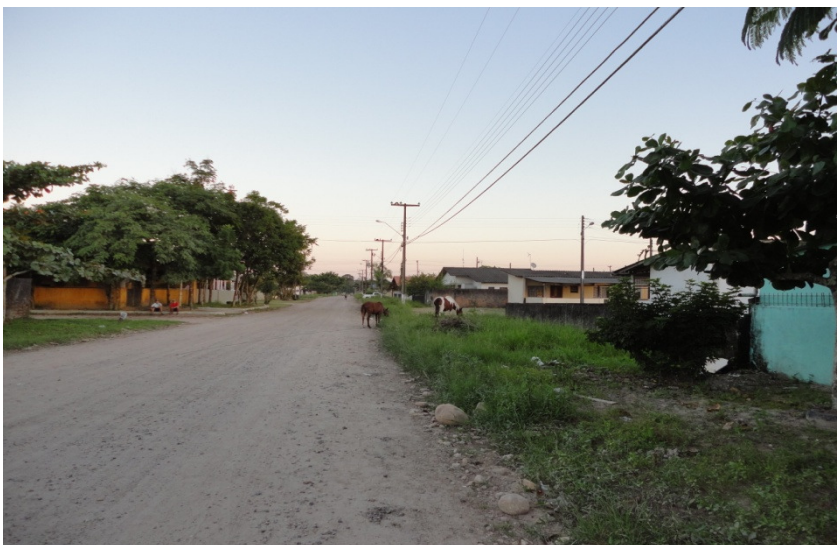
RUA PRINCIPAL SEM PAVIMENTAÇÃO FONTE: RODRIGUES, L. A. (2011).
