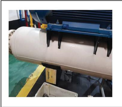
O separador de NH<sub>3</sub> é responsável por remover com eficácia o óleo do gás de descarga do compressor e retorna o óleo para o cárter do compressor através de uma válvula boia de alta precisão, ou para um sistema de controle de óleo
