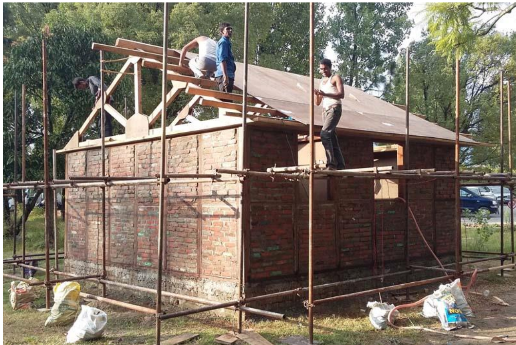
FIGURA 4.25 – INSTALAÇÃO DAS TRELIÇAS DO TELHADO
