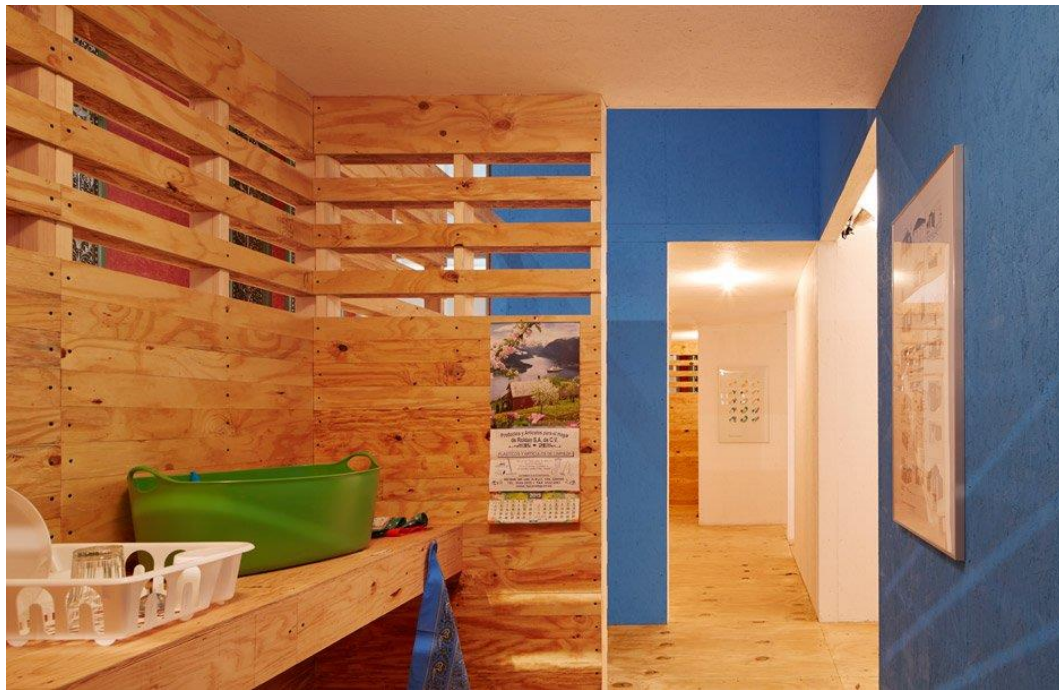
FIGURA 4.11 – VEDAÇÃO TRABALHADA COM PALLETS
