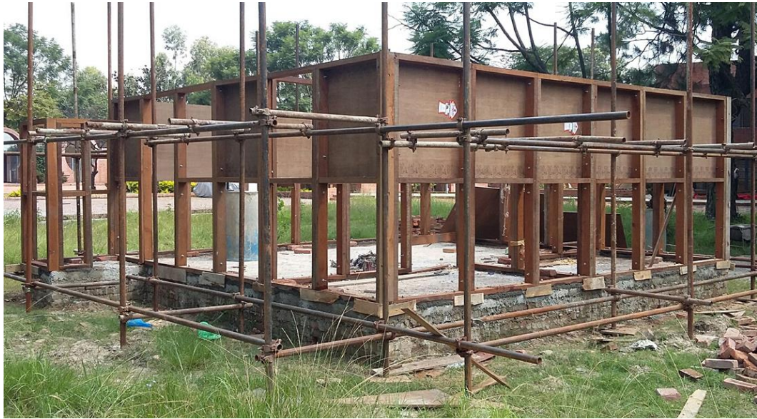
FIGURA 4.23 – INSTALAÇÃO DOS PAINÉIS AUTOPORTANTES
