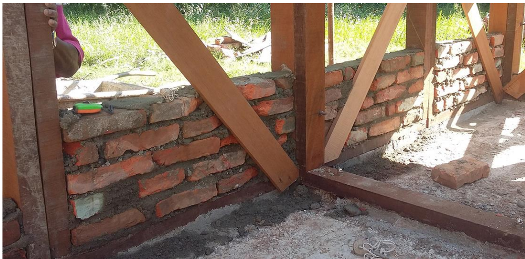
FIGURA 4.24 – VEDAÇÃO DOS PAINÉIS INDEPENDENTE DA ESTRUTURA
