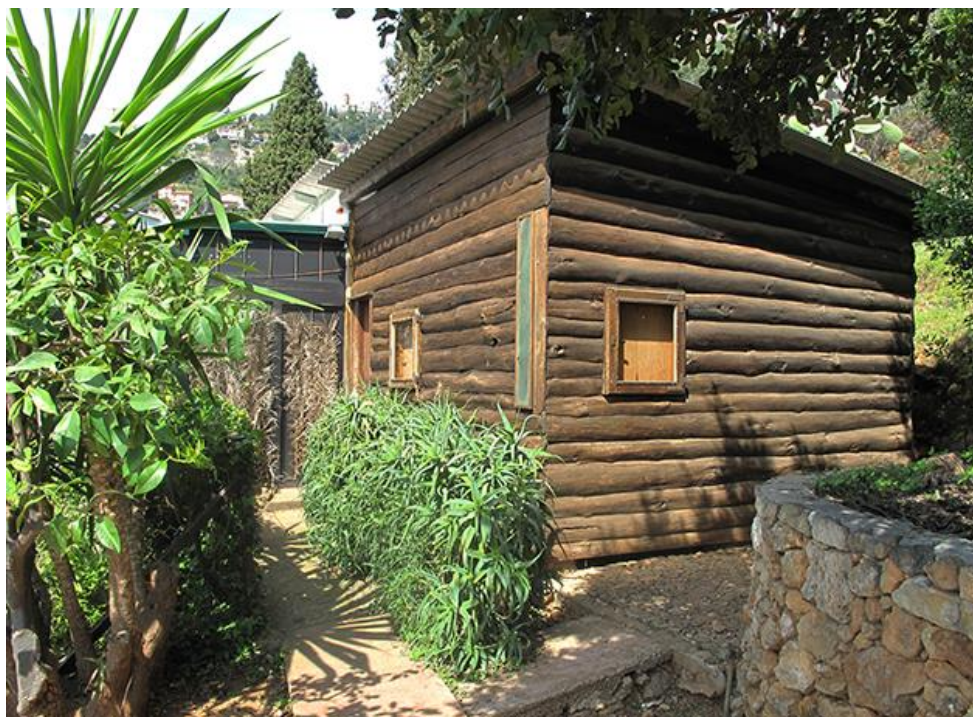
FIGURA 5.7 – VISTA EXTERNA DA CASA
