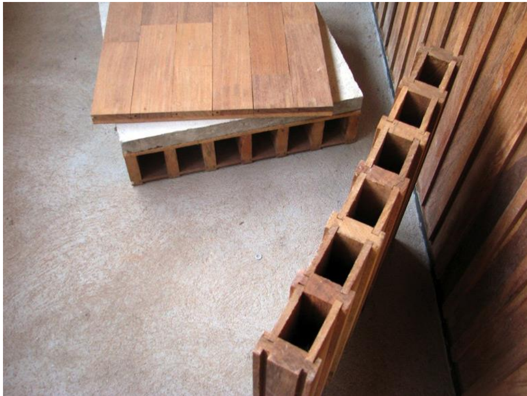
FIGURA 4.5 – ESQUEMA DE PAINEL DA VEDAÇÃO E PISO
