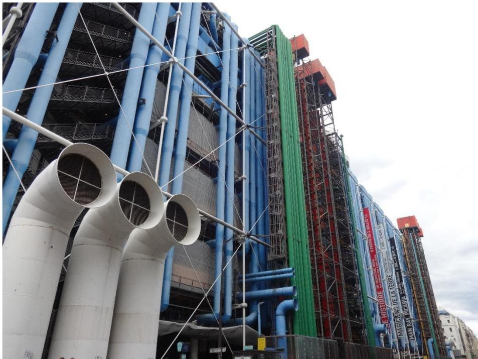
**FIGURA 9** – Detalhe da fachada da Rua *Beaubourg* com as tubulações de serviço coloridas.
