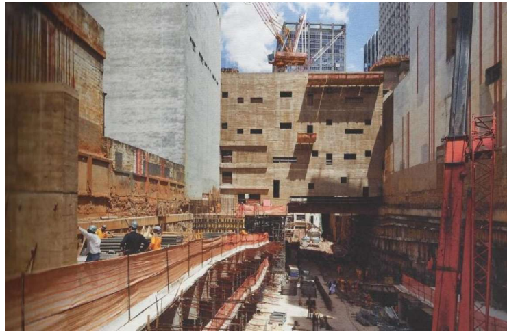
Figura 77 - Vista da construção por um dos terraços. (Fonte: NOSEK, 2013, p. 61).
