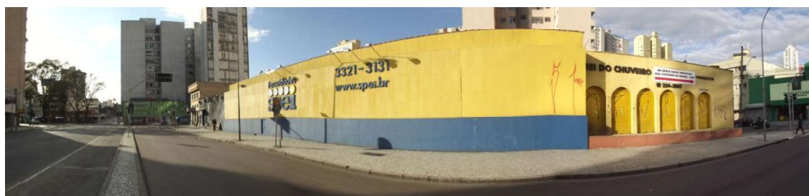
Figura 90 - Panorâmica da Fachada à Rua Visconde de Nácar. (Fonte: Autor).
