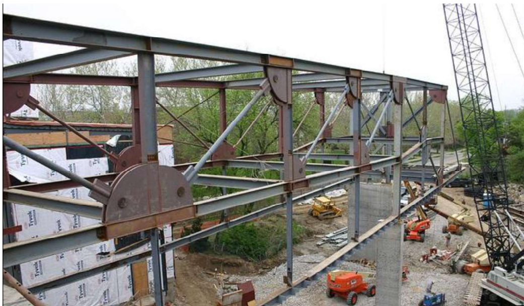
Figura 45 - Finalização da estrutura metálica treliçada e atirantada do bloco em projeção sob o lago. (Fonte: Flickr, 2013).
