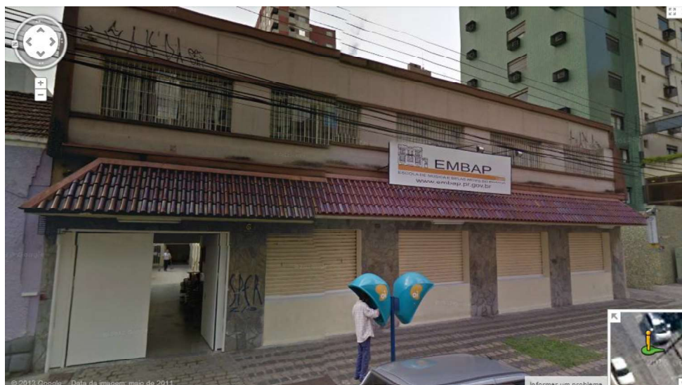
Figura 86 - Edifício à Rua Francisco Torres, 253. (Fonte: Google Maps, 2013)
