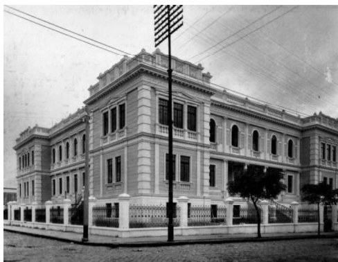
Figura 83 - Primeiro edifício da EMBAP na Rua Emiliano Perneta nº 50. (Fonte: SEEC-PR, 2013).
