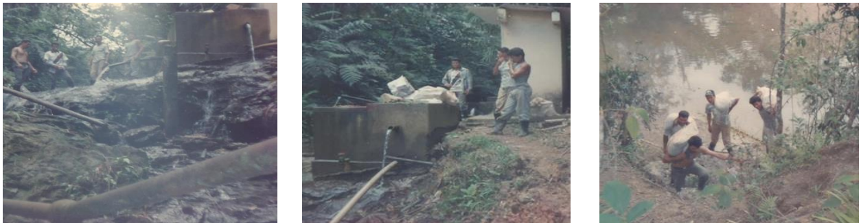
FIGURA 2 - MORADORES CONSTRUINDO O SISTEMA DE ABASTECIMENTO DE ÁGUA EM 1997.
