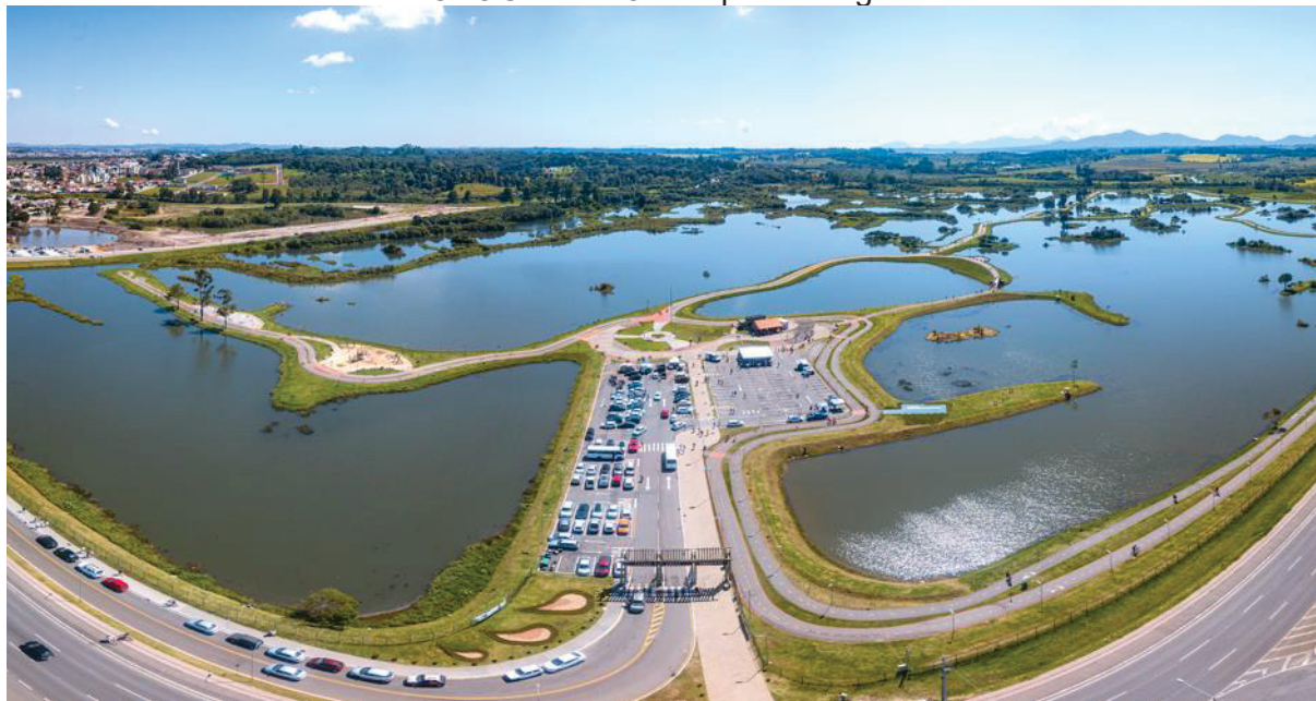
FOTOGRAFIA 8: Parque das Águas
