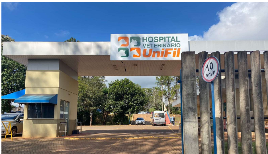
FIGURA 8 - Portaria do Hospital Veterinário UniFil, na Cidade de Londrina, Paraná, Brasil
