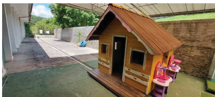
FIGURA 50 - LATERAL EXTERNA COBERTA
