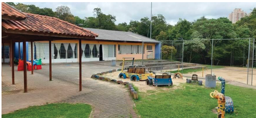
FIGURA 36 - BLOCO DA EDUCAÇÃO INFANTIL E ÁREA EXTERNA
