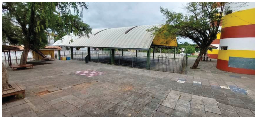
FIGURA 41 - QUADRA COBERTA NA FRENTE DO PRÉDIO DA EDUCAÇÃO INTEGRAL EM TEMPO AMPLIADO
