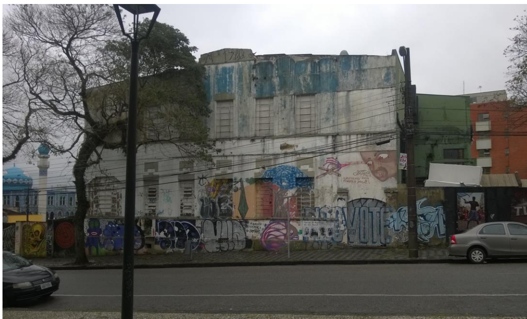
FIGURA 5.5 – Edificação existente – abandonada e depredada. Fonte: A autora, 2017.
