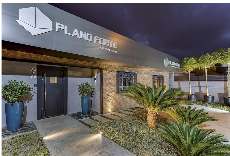
FIGURA 4.17 – Plano Forte Coworking – Fachada. Fonte: HABITARE, 2017.
