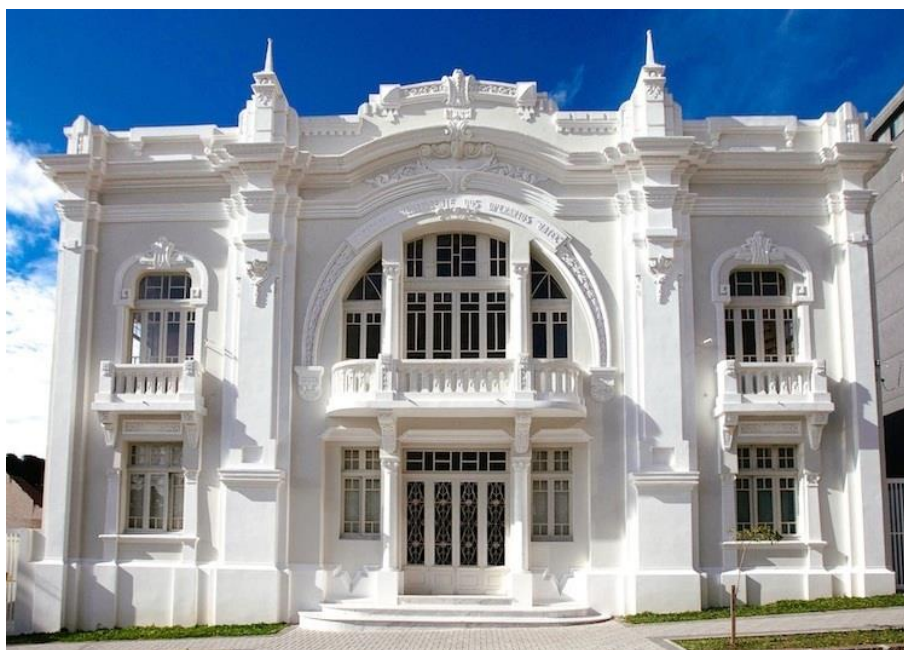
FIGURA 4.11 – Fachada do Nex Curitiba, localizada no bairro Batel Fonte: IZAZILLI, 2017.
