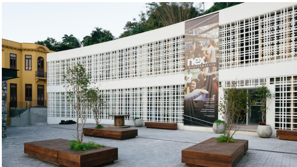
FIGURA 4.7 – Fachada do coworking Nex Rio. FONTE: NEX COWORKING, 2015.
