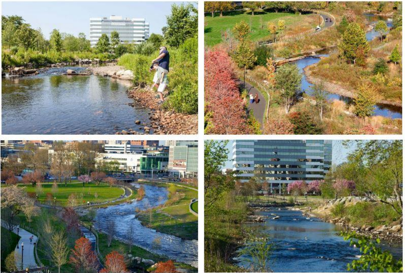
FIGURA 10 – APÓS A EXECUÇÃO DO PROJETO, O RIO HOJE CORRE LIVRE.
