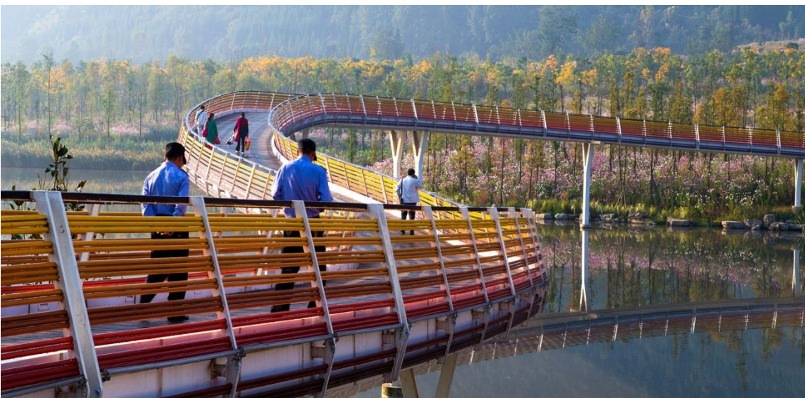
FIGURA 14 – PASSARELA ACIMA DO RIO.
