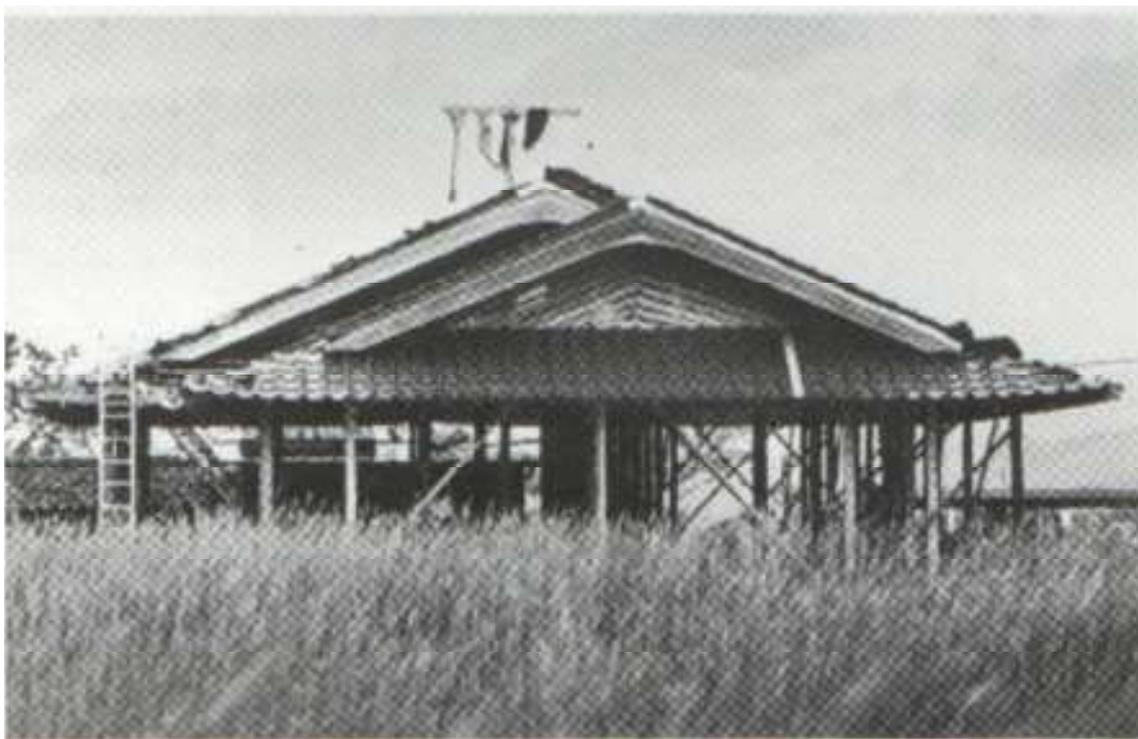
FIGURA 6 – ESTRUTURA DE TELHADO COM PILARES, SEM PAREDES.
