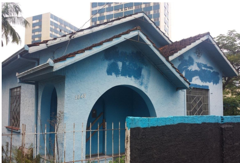
FIGURA 43 – CASA ABANDONADA NA ESQUINA DA AV. ANITA GARIBALDI COM A R. EÇA DE QUEIROZ.
