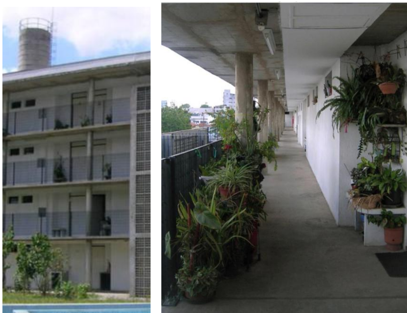
FIGURA 33 – APROPRIAÇÃO DO ESPAÇO NOS RECUOS DAS PORTAS DAS UNIDADES, ONDE ESTÃO POSICIONADOS OS BANCOS DE CONCRETO.
