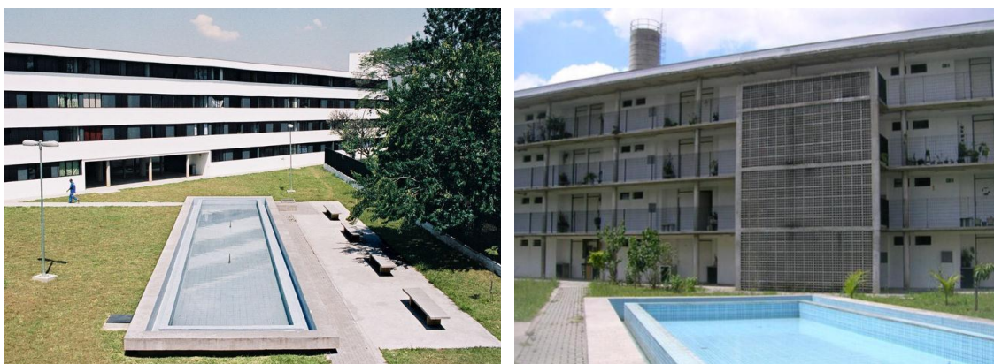
FIGURA 32 – FACHADAS DEMARCADAS POR FAIXAS DE ALVENARIA BRANCA INTERCALADAS POR FAIXAS ESCURAS DAS JANELAS OU PELAS COLUNAS E PELA CIRCULAÇÃO HORIZONTAL.
