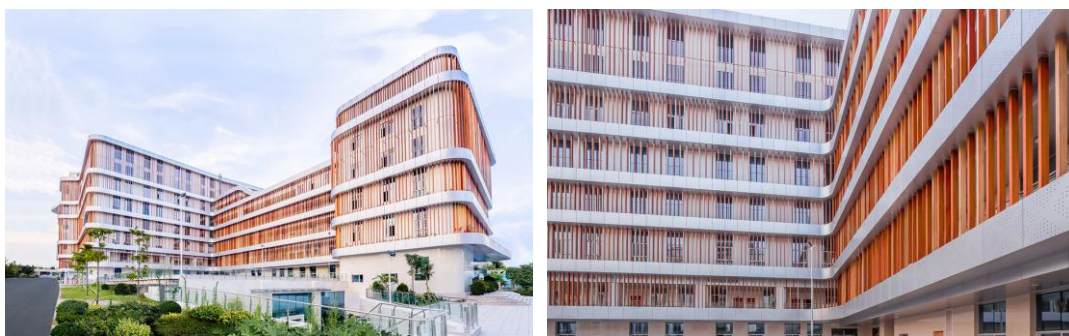
FIGURA 14 - FACHADAS DINÂMICAS COMPOSTAS DE PLANOS METÁLICOS QUE DEMARCAM OS PAVIMENTOS E ELEMENTOS VERTICAIS DE MADEIRA E ALUMÍNIO.
