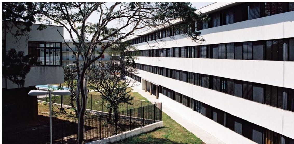
FIGURA 28 – CERCA METÁLICA QUE ISOLA A BIBLIOTECA DO CONJUNTO HABITACIONAL, PREJUDICANDO A PERMEABILIDADE E INTEGRAÇÃO ENTRE OS DOIS.
