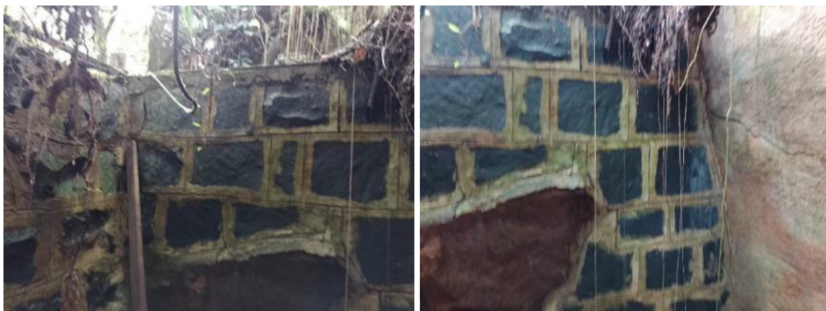
Figura 4.25 Registro das paredes no interior na capela.
