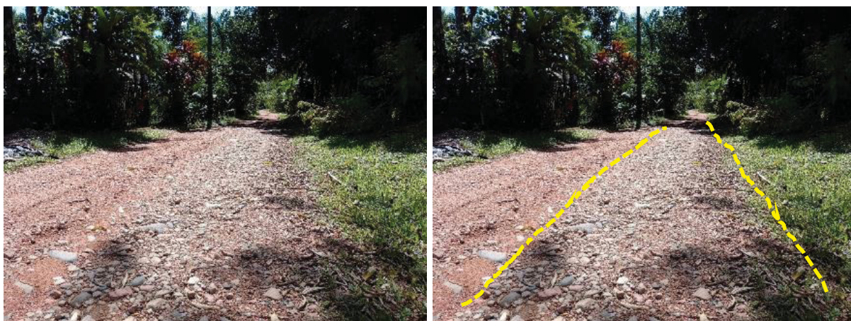
Figura 4.39 Registro de cascalhos em metade da largura, em trecho próximo ao alto da estrada do Anhaia. À direita, entre as linhas tracejadas é apresentada suposto calçamento (coordenadas UTM 22S 713.763 e 7.171.054).
