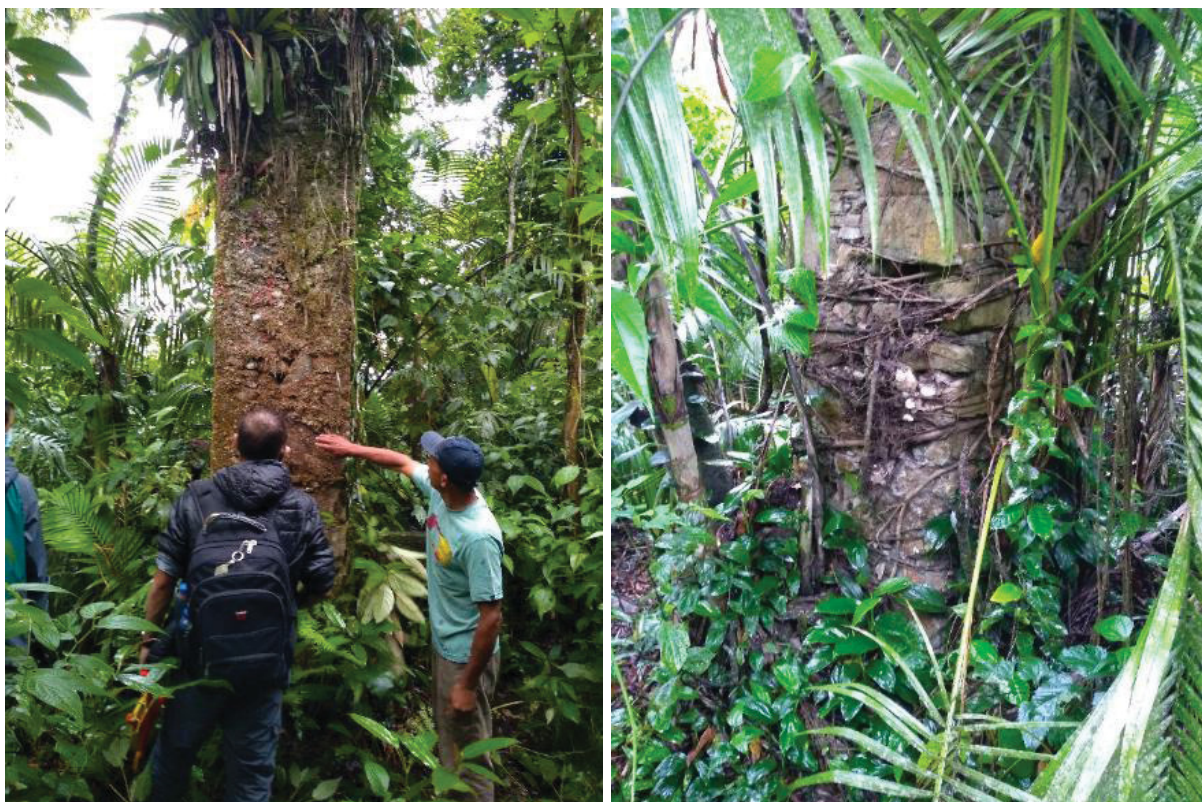
Figura 4.12 Registro de colunas e muretas recobertas pela vegetação.
