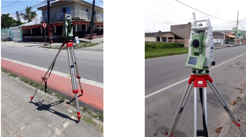
FIGURA 3.8 – ESTAÇÃO ROBÓTICA INSTALADA NOS PONTOS LEVANTADOS
