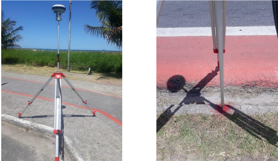
FIGURA 3.2 – RASTREIO DOS PONTOS DE APOIO COM O EQUIPAMENTO GNSS LEICA GS15
