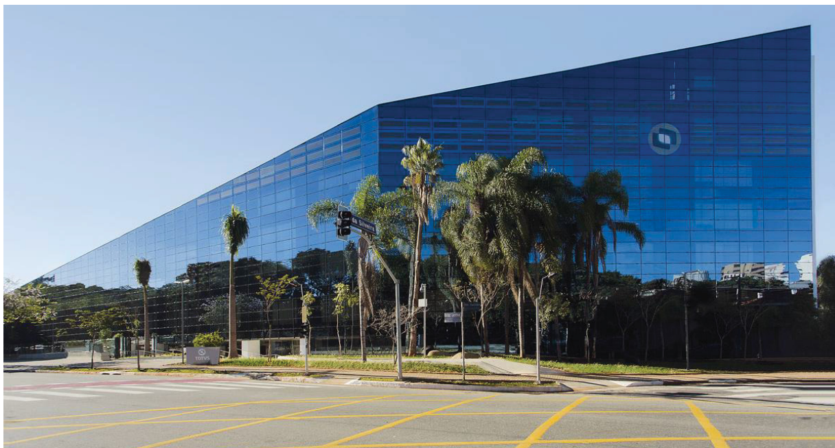
FIGURA 34 - FACHADA DO EDIFÍCIO SÊNECA (ARCOWEB, 2020)
