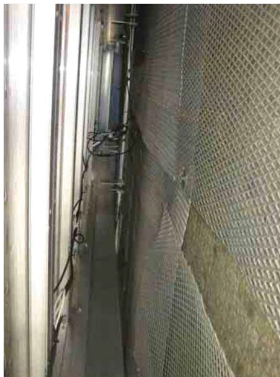
FIGURA 25 - ESPAÇO ENTRE OS MÓDULOS EXTERNOS E O ANTIGO REVESTIMENTO INTERNO DE MOSAICOS (YUMPU 2020)
