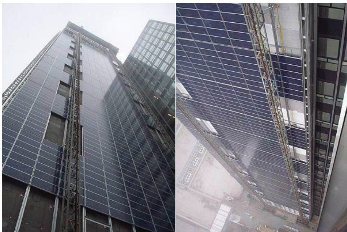
FIGURA 24 - TORRE DE SERVIÇO MANCHESTER CIS TOWER (GIGAZINE, 2007)
