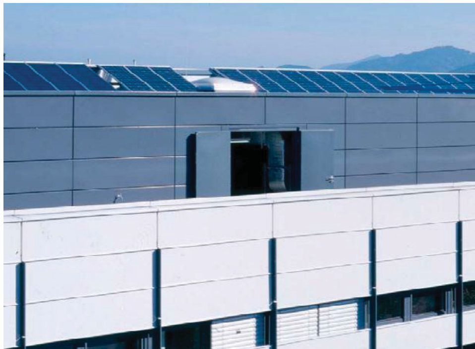
FIGURA 31 - IMAGEM DO SISTEMA FOTOVOLTAICO E MECANISMOS DE VEDAÇÃO NO TELHADO FRAUNHOFER ISE (PVDATABASE, 2020)
