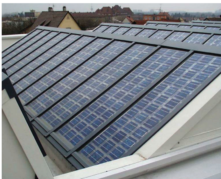
FIGURA 29 - TETO EM SHED: FRAUNHOFER ISE (PVDATABASE, 2020)
