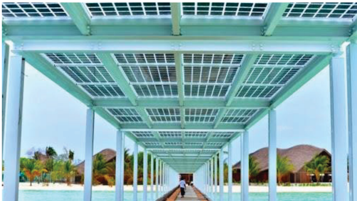
FIGURA 23 - VISTA DA PASSARELA DO RESORT (YYA, 2020)
