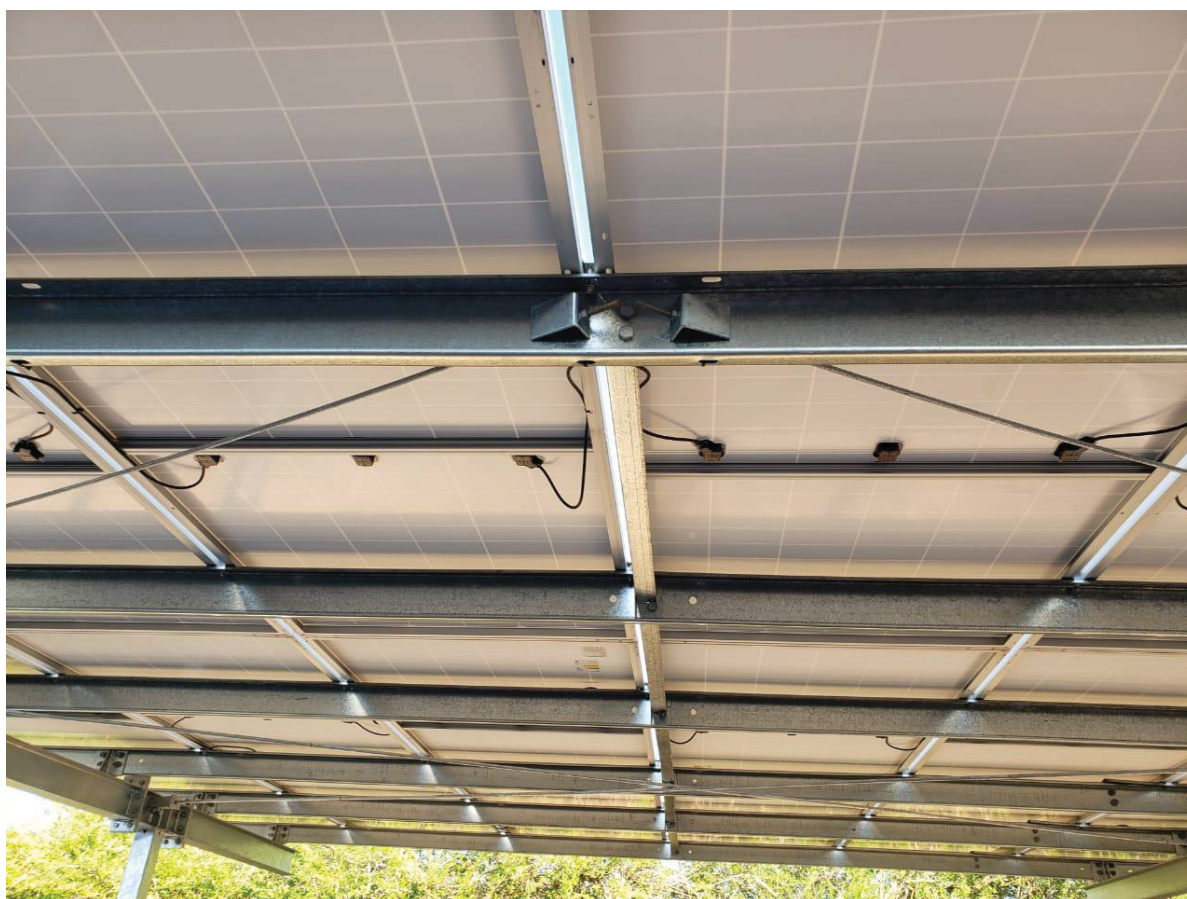
FIGURA 38 - IMAGEM DO CARPORT INSTALADO NA UNIVERSIDADE FEDERAL DO PARANÁ (A AUTORA, 2020)
