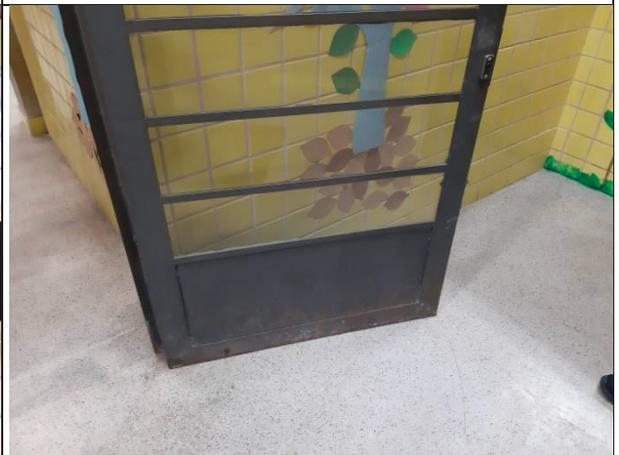
Início do processo de corrosão em porta metálica
