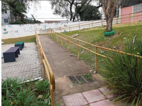
Corrimão da rampa em processo de corrosão
