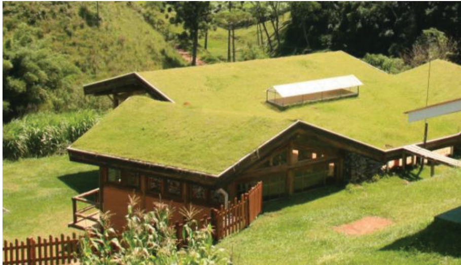
Figura 8: Telhado verde do tipo extensivo
