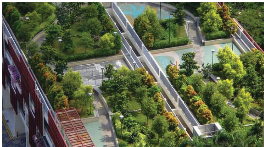
Figura 6: Telhado verde do tipo intensivo
