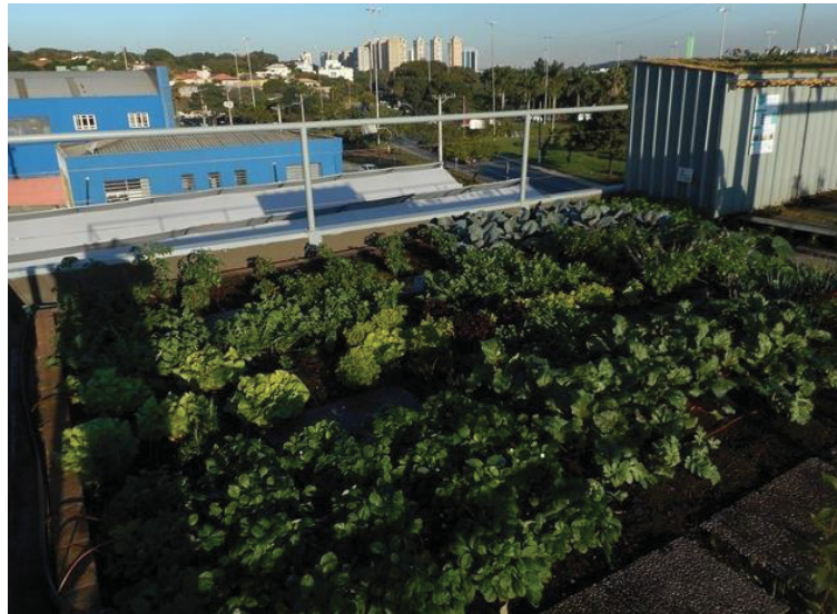
Figura 7: Telhado verde do tipo semi-intensivo
