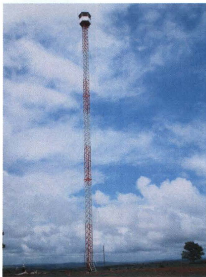
FIGURA 4 – TORRE DE OBSERVAÇÃO DE INCÊNDIO
