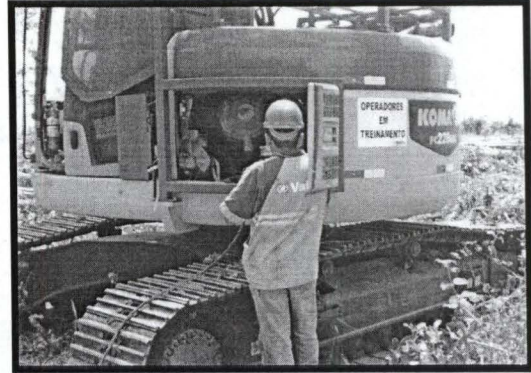
Figura 69: Manutenção dos equipamentos
