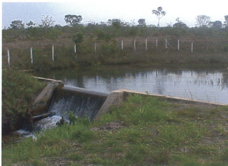
Figura 10 – Captação de água no Córrego Lageadinho, para abastecimento urbano Fonte: FEMA/ 2002
