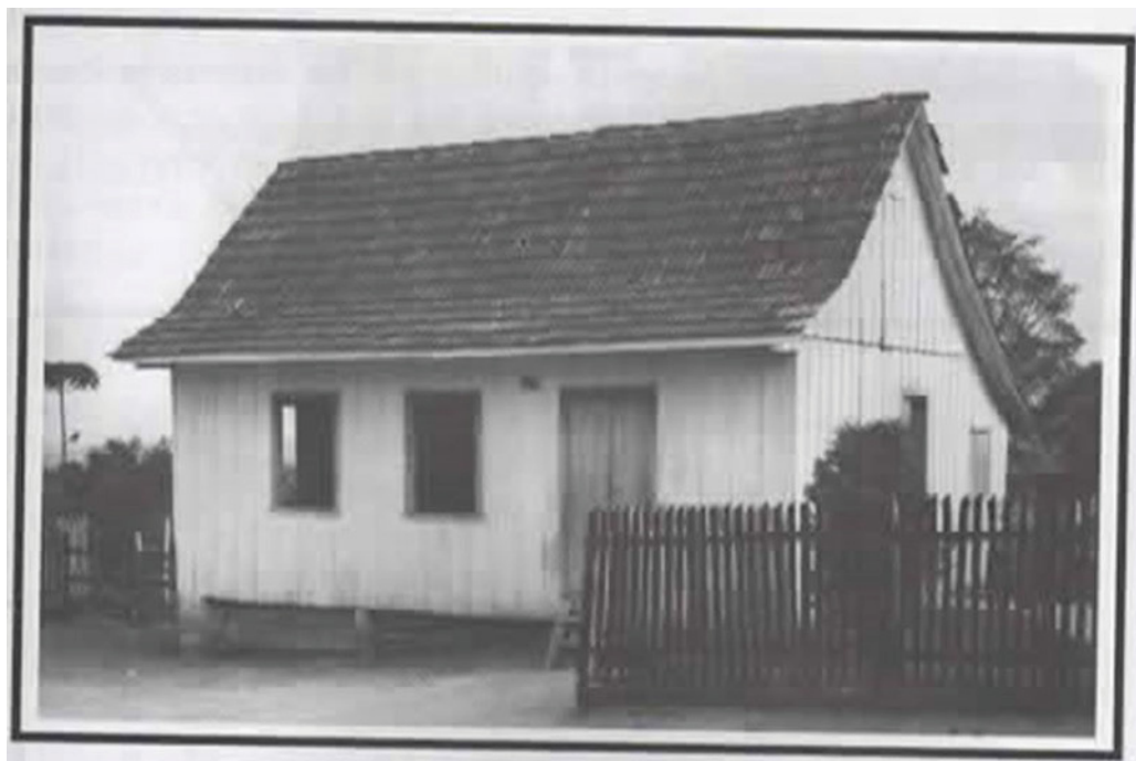
FIGURA 6 - Antiga Escola Isolada do Campina da Barra, atualmente Escola Municipal Pedro Biscaia
