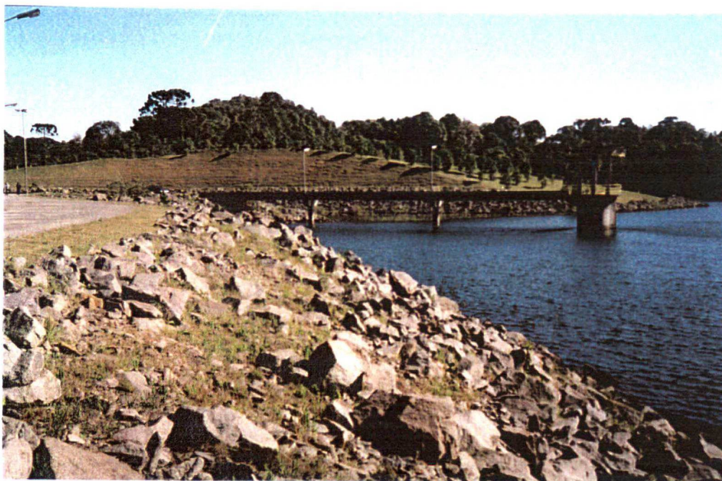
Figura 2. Reservatório Piraquara I na região da barragem. Ao fundo, nota-se a plataforma de tomada de água, local da coleta.
