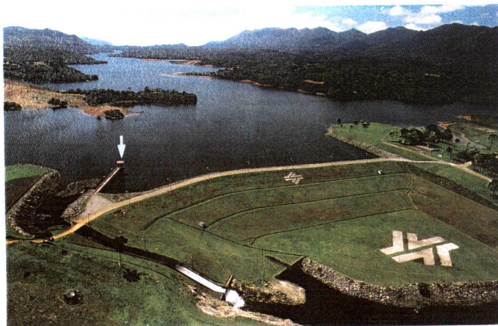
Figura 3. Vista aérea do Reservatório Piraquara I, indicando a estação de coleta.
