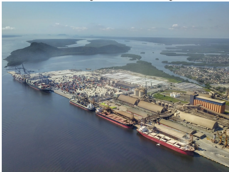
FIGURA 3 - Imagem aérea do Porto de Paranaguá PR
