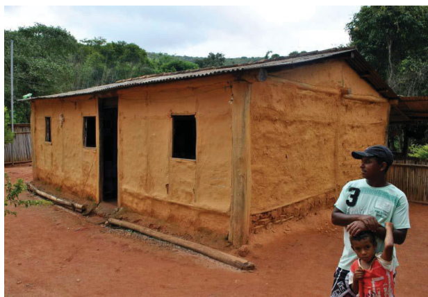
Figura 10 – Residência de pau-a-pique pintada com a técnica do “barreado”
