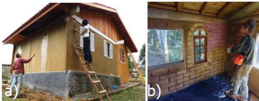
Figura 19 – Pintura de paredes externas em Colombo – PR (a) e parede interna em São Bernardo do Campo – SP (b)
