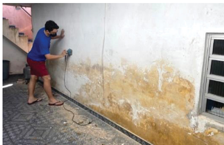
Figura 67 – Preparação da parede externa no workshop em Guarulhos - SP
