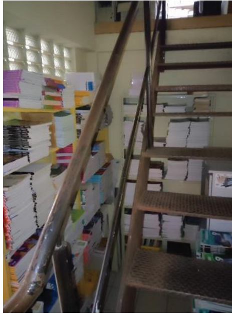
FIGURA 19 - ESCADA DE ACESSO AO SÓTÃO
