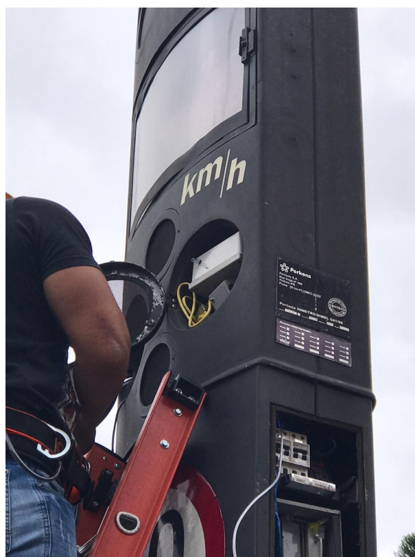
Figura 7 – Instalação do SDS011 na lombada eletrônica. Fonte: O Autor (2021).
