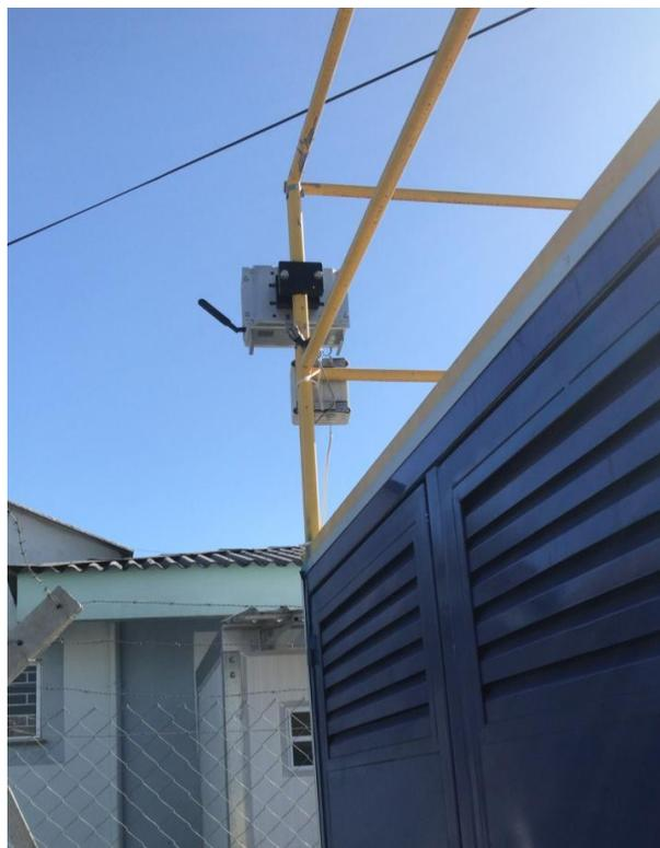
**Figura 8.** Instalação da estação Alfa para comparação externa. Abaixo dela, o armário contendo o equipamento de referência.
