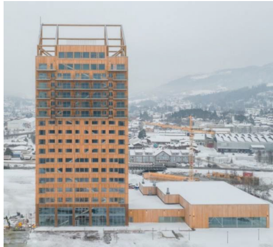
Figura 35 - Edifício Mjøstårnet (Noruega) de construção mista de Madeira Lamelada Colada (MLC) e painéis de Madeira Lamelada Colada Cruzada (MLCC).
