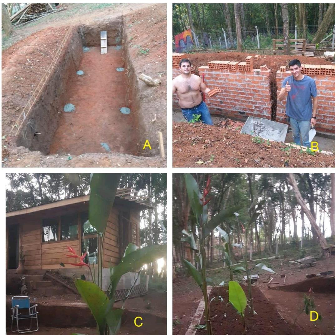
FIGURA 9: Fases da construção da BET e características locais. A. Recorte do solo onde foi construída a BET; B. Morador e outro colaborador participam do processo de construção; C. Localização da BET em relação à residência; D. As diferentes espécies plantadas na bacia de evapotranspiração. Fonte: Refúgio Mar de Nuvens/ Projeto Baná (2020, não publicado).
