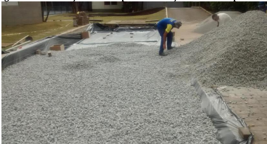
Figura 20 – Colocação de brita para construção da base do pavimento
