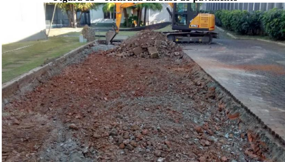
Figura 13 – Retirada da base do pavimento
