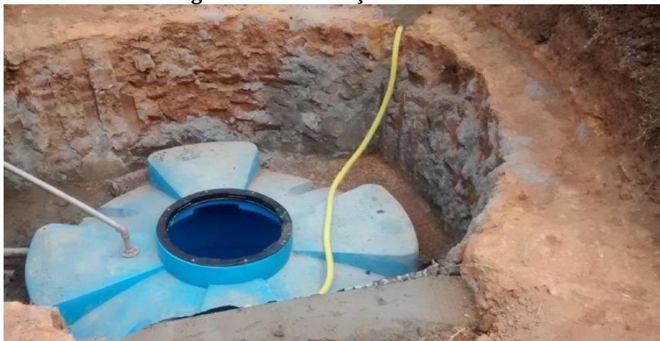
Figura 18 – Instalação da cisterna
