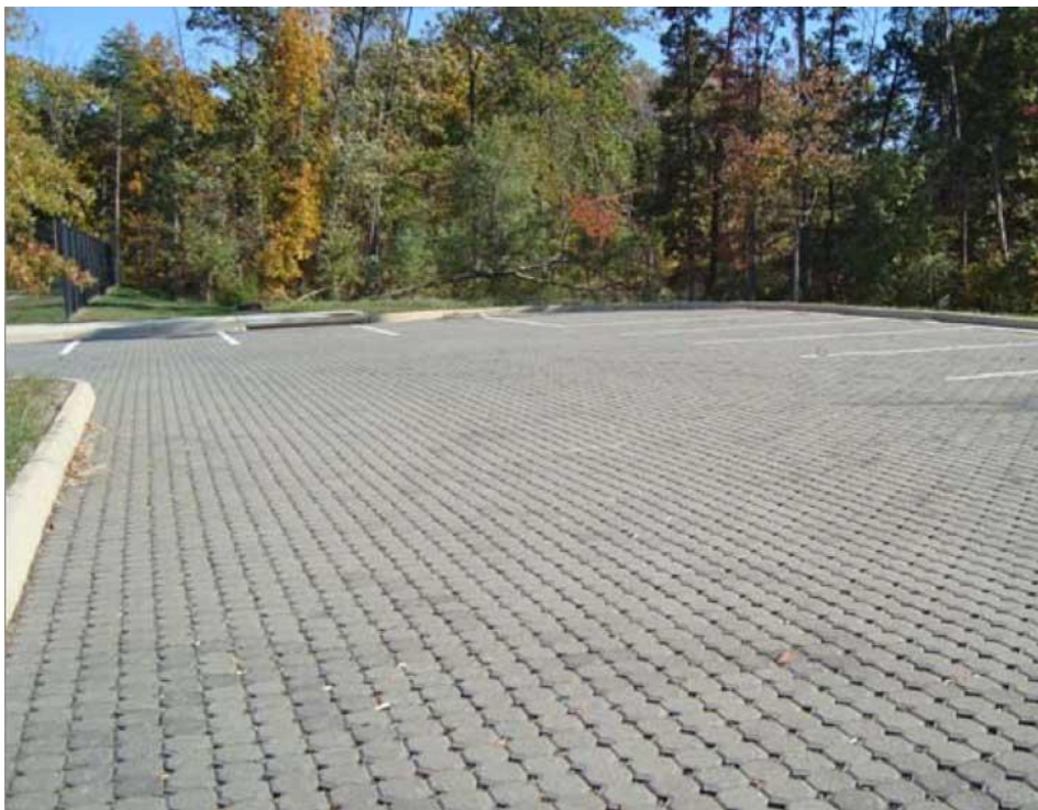
Figura 8 – Exemplo de pavimento permeável (intertravamento)
