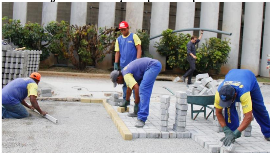
Figura 23 – Colocação do pavimento permeável
