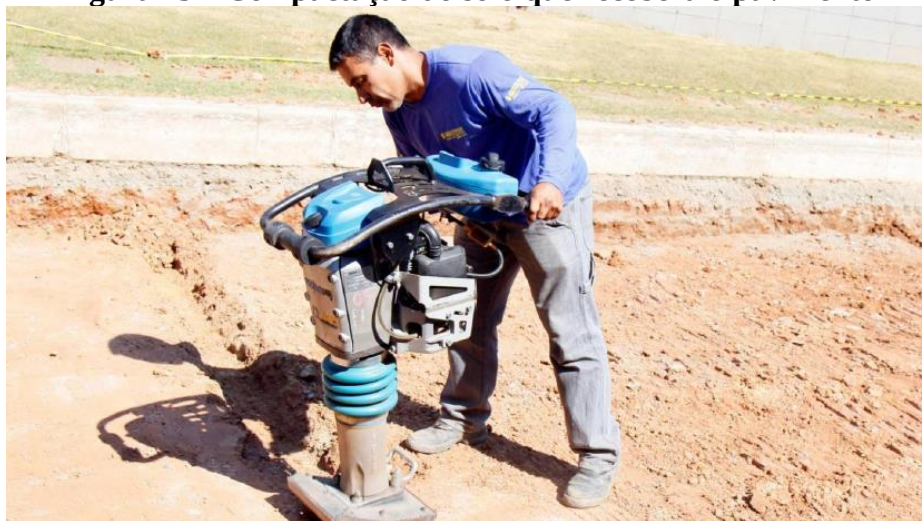
Figura 15 – Compactação do solo que receberá o pavimento
