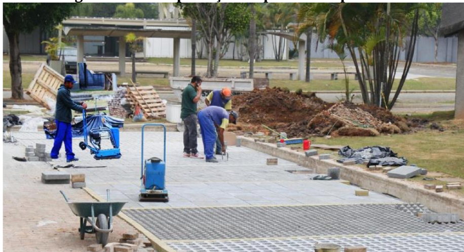
Figura 25 – Compactação do pavimento permeável
