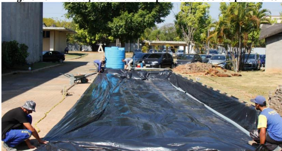
Figura 16 – Instalação de manta impermeável sobre o pavimento
