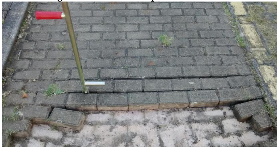
Figura 12 – Retirada do pavimento existente
