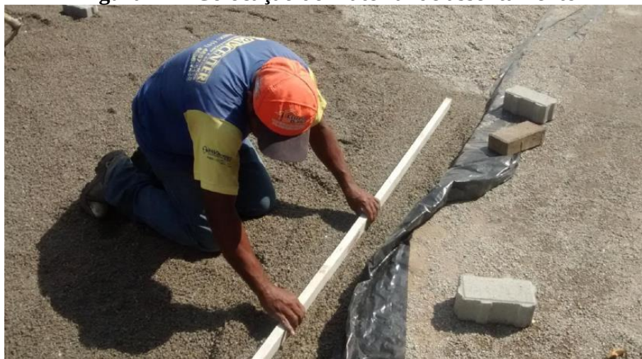
Figura 22 – Colocação do material de assentamento
