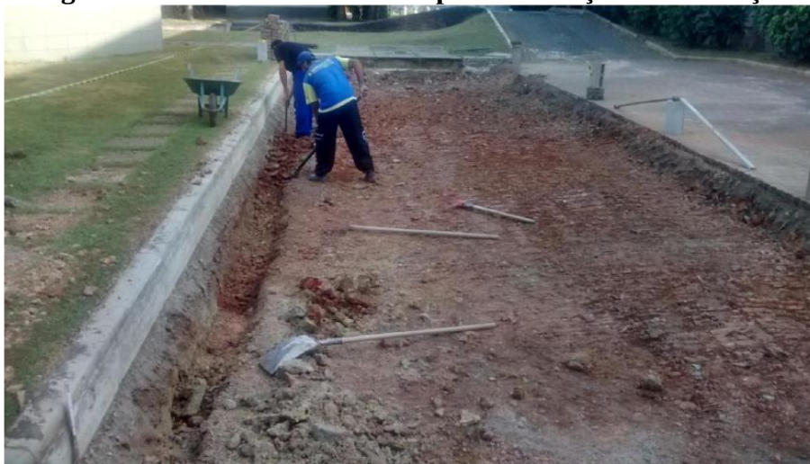
Figura 14 – Aberturas das valas para instalação da tubulação
