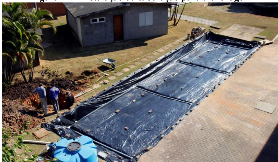
Figura 17 – Instalação da tubulação para a drenagem
