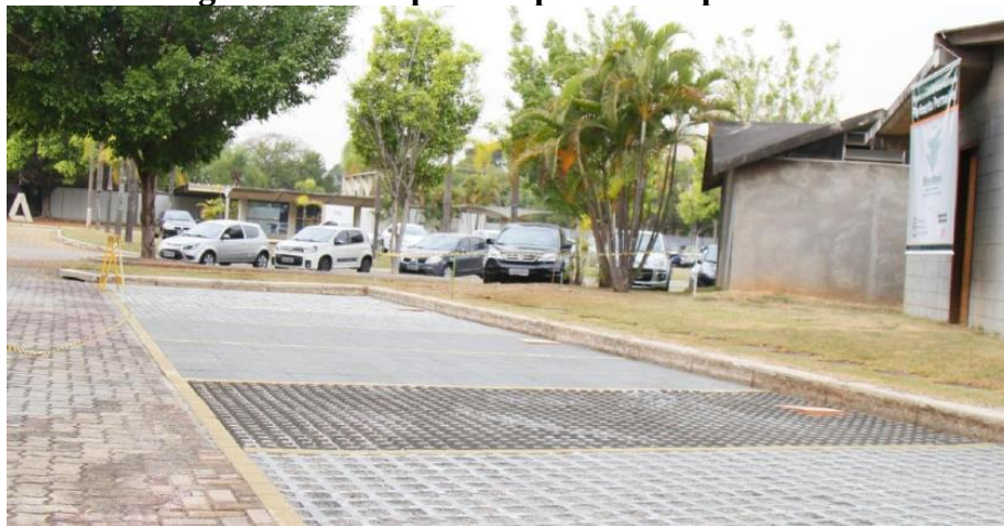
Figura 26 – Limpeza do pavimento permeável
