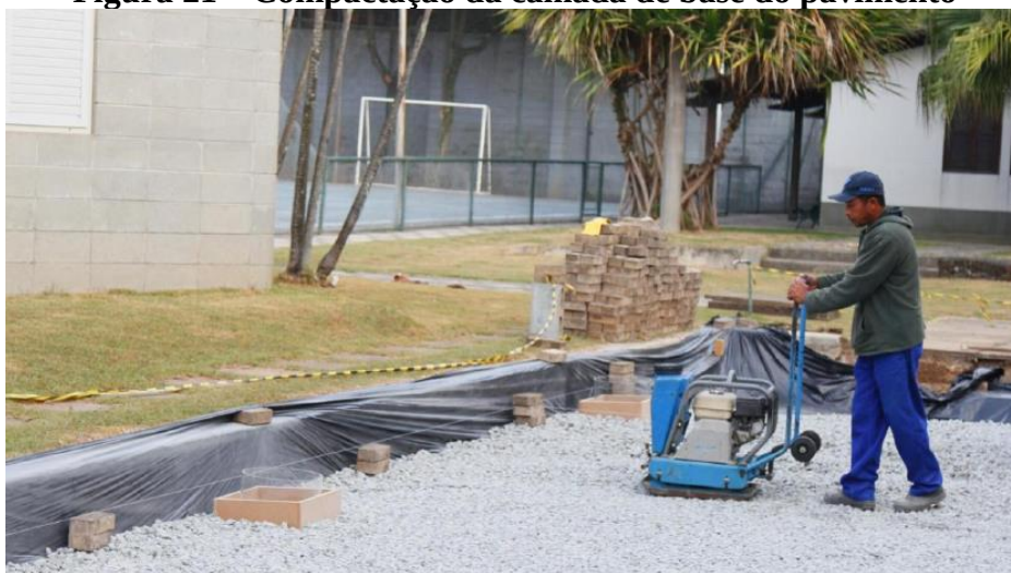
Figura 21 – Compactação da camada de base do pavimento
