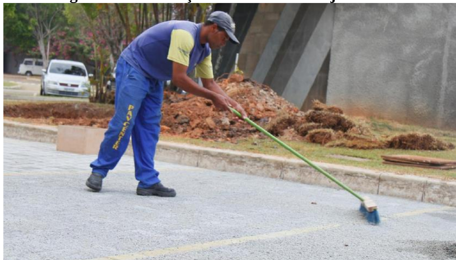
Figura 24 – Colocação do material de rejuntamento
