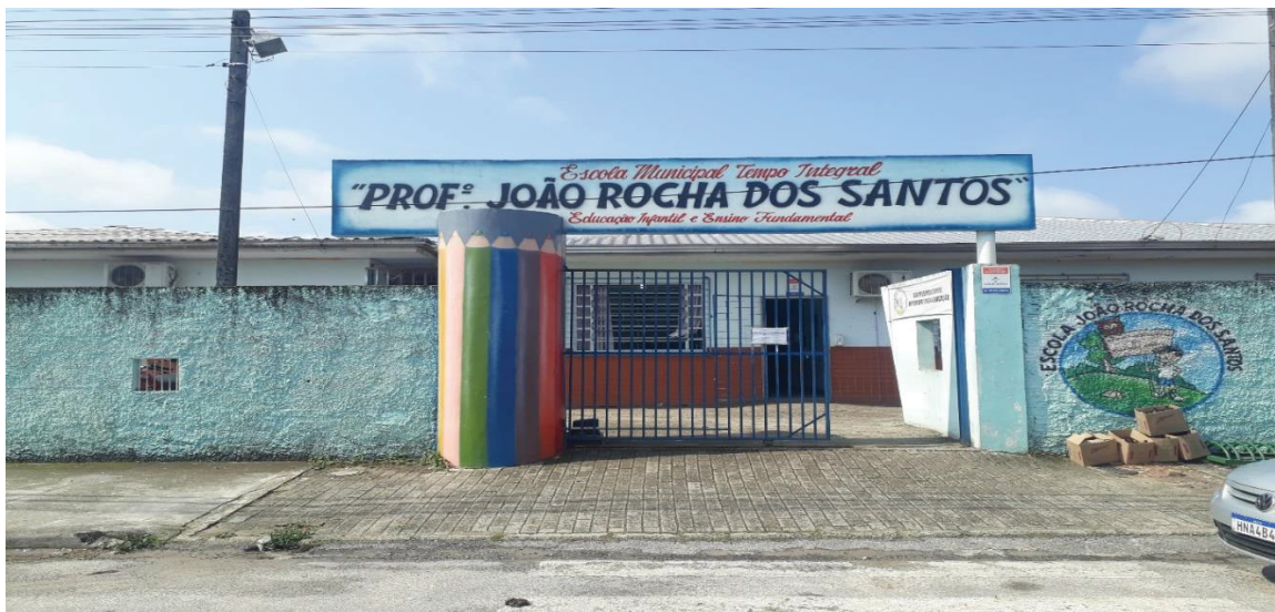
FIGURA 1 – Fachada da Escola Prof. João Rocha dos Santos
