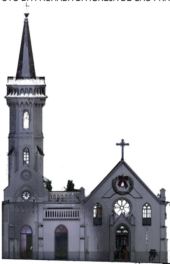
FIGURA 23 – ORTOFOTO DA FACHADA DA IGREJA DE SÃO FRANCISCO DE CHAGAS
