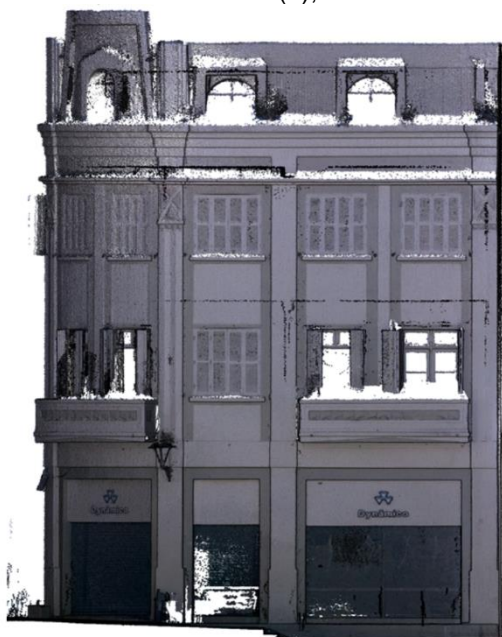
FIGURA 52 - PRÉDIO DYNÂMICO (2), VISTA RUA JOSÉ BONIFÁCIO
