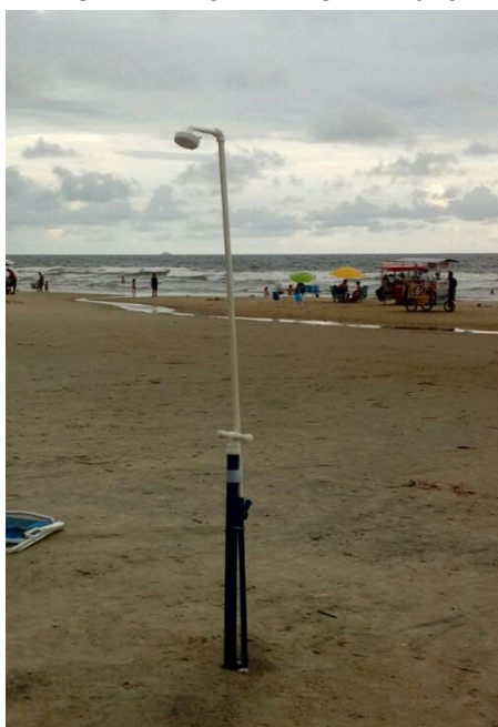
FIGURA 1 - CHUVEIRO ECOLÓGICO INSTALADO NA PRAIA DE PONTAL DO PARANÁ - PR DURANTE O VERÃO DE 2018
