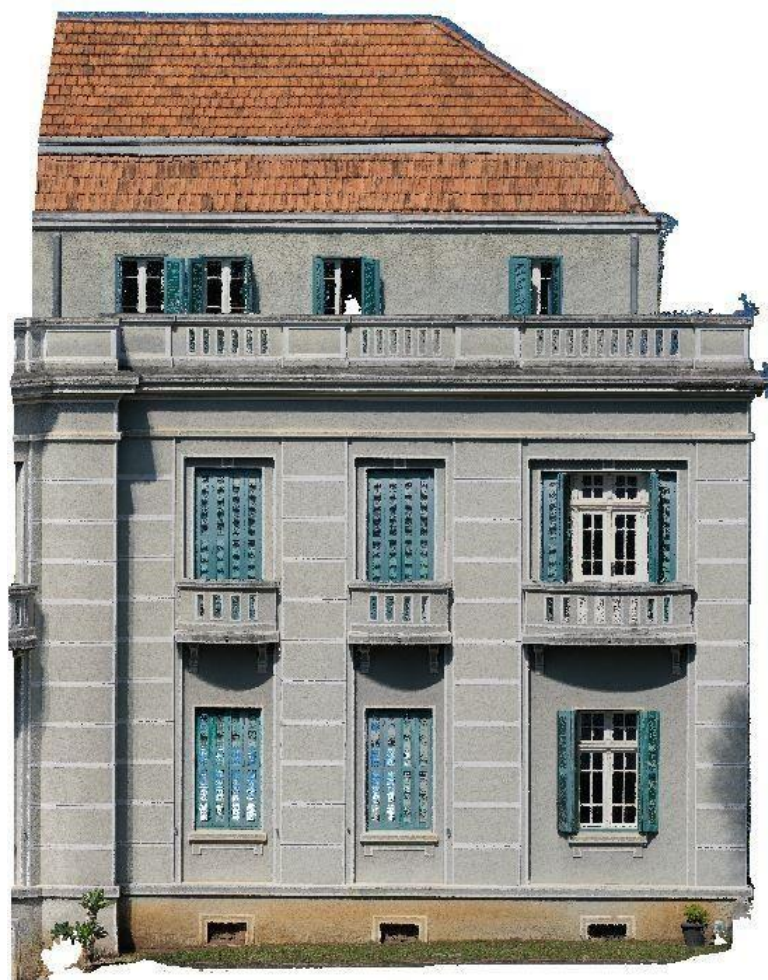
FIGURA 40 – NUVEM DE PONTOS DA FACHADA
