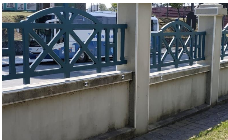
FIGURA 9 – PONTOS DE APOIO NO MURO
