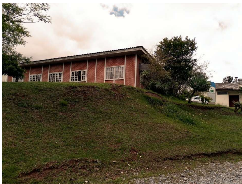
Figura 20 - Talude próximo a edificação USOC
