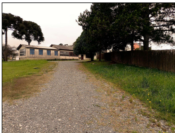
Figura 6 - Entrada Via Secundária para acesso ao Prédio da DCF
