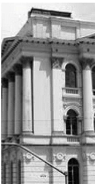
Figura 12: Quebrados até a divisa. Fonte: Autor (2012)
