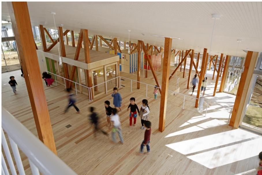
FIGURA 24 – Pilares quadrados de madeira estruturam a edificação.
