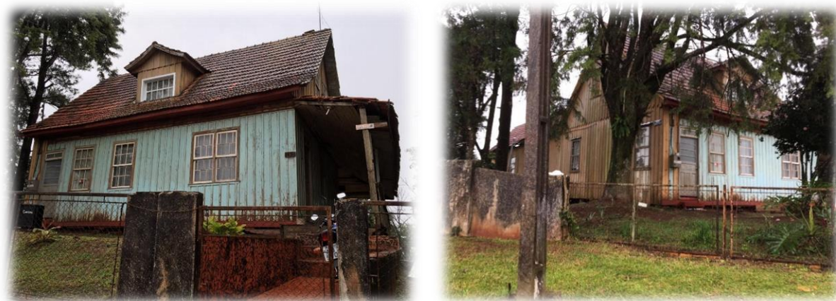
FIGURA 89: A EDIFICAÇÃO A SER PRESERVADA FONTE: A autora (2016)
