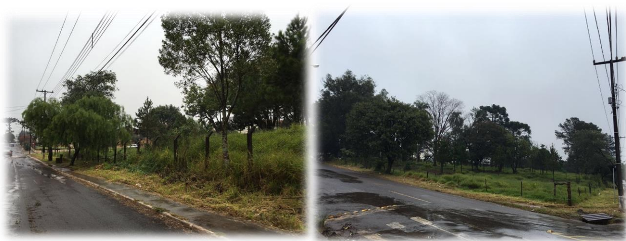
FIGURA 84: VISTA DA AVENIDA JOSÉ CAMPIGOTTO E ESQUINA COM A RUA EZÍDIO BOZA FONTE: A autora (2016)
