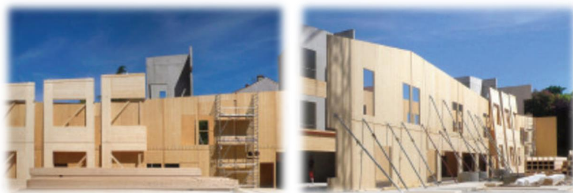
FIGURA 53: CONSTRUÇÃO DA ESCOLA: PAINÉIS SENDO MONTADOS IN LOCO FONTE: LEGNO ARCHITETTURA (2016, pg. 12)
