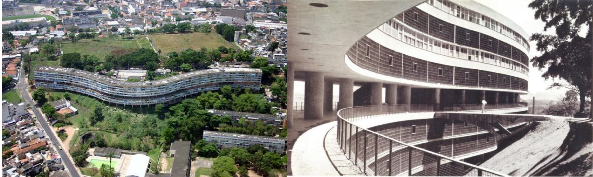
FIGURA 2.3 – FOTOS EXTERNAS DO CONJUNTO RESIDENCIAL PEDREGULHO.
