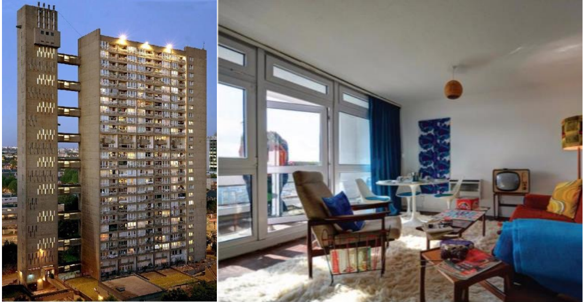
FIGURA 3.11 – FOTO E INTERIOR DE APARTAMENTO DO EDIFÍCIO “BALFON TOWER”
