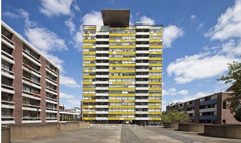
FIGURA 3.8 – EDIFÍCIO GREAT ARTHUR HOUSE, NO CONDOMÍNIO GOLDEN LANE
