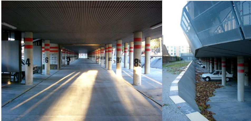
FIGURA 3.63 – ESTACIONAMENTO DO EDIFÍCIO NEMAUSUS
