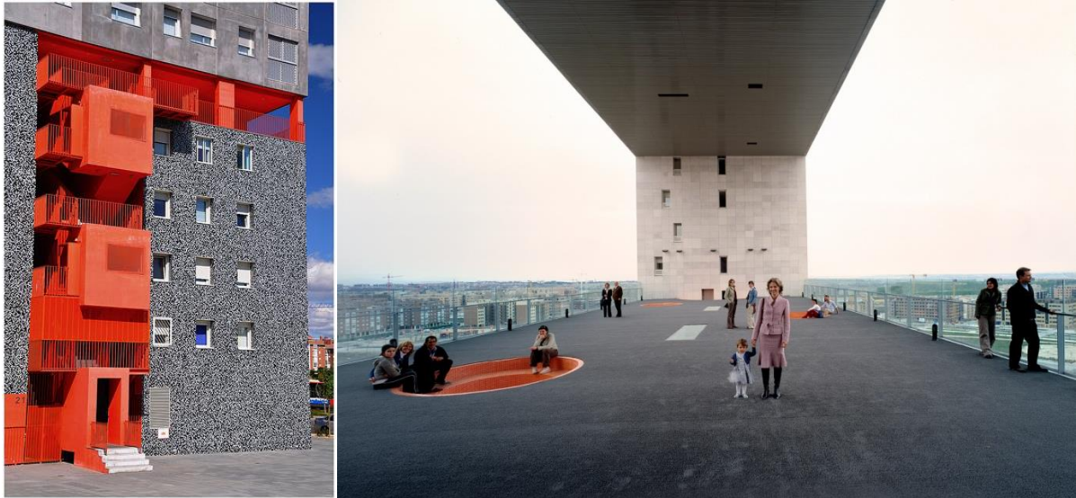
FIGURA 3.28 – CIRCULAÇÃO E “PRAÇA NO CÉU” DO EDIFÍCIO “MIRADOR”
