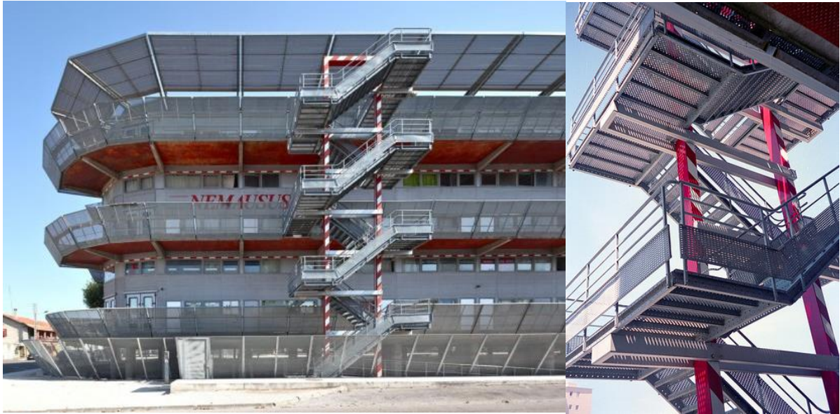
FIGURA 3.59 – ESCADAS DO CONJUNTO NEMAUSUS
