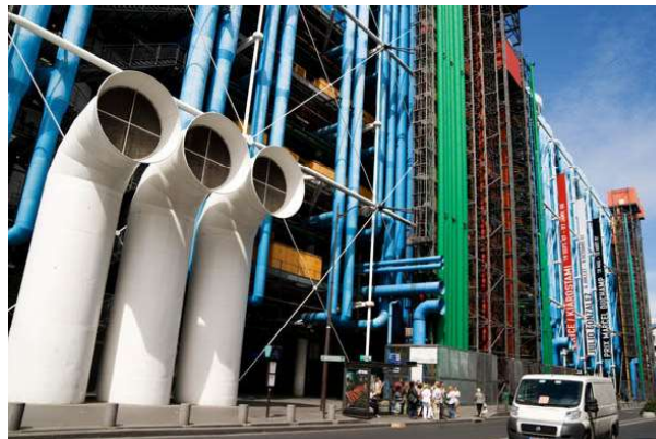
Figura 30 – Tubulações na fachada da Rua Renard
