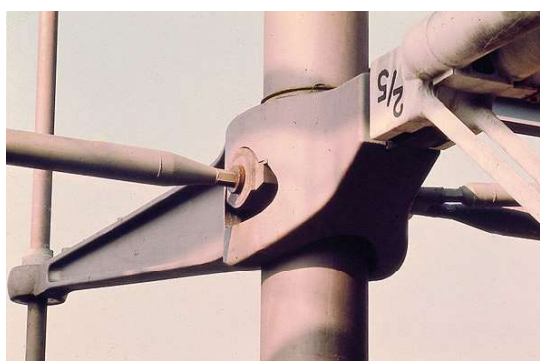
Figura 29 – Gerberette interligando pilar, vigas e tirantes
