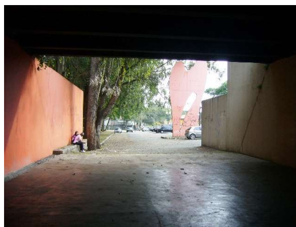
Figura 77 – Galeria de acesso à praça
