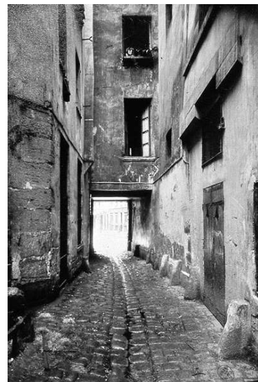
Figura 12 – Ruela antes da demolição
