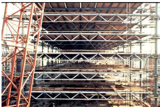
Figura 27 – Vigas em treliças
