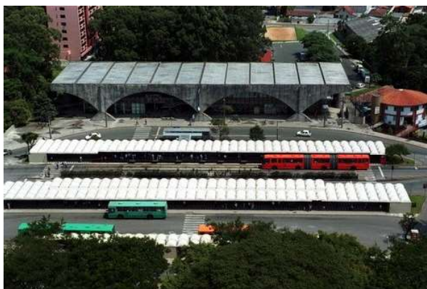
Figura 74 – MUMA e o Terminal do Portão
