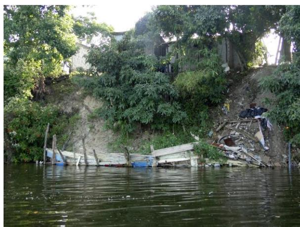
Figura 75. Contenção supostamente conter a erosão na encosta do rio. Fonte: Pesquisa de campo. Ano: Mai./2013.
