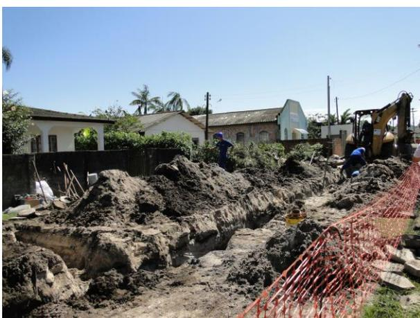
Figura 48. Obras para a tubulação do esgoto -3.
