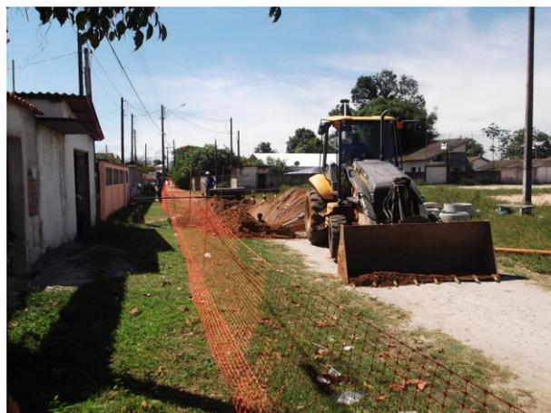
Figura 47. Obras para a tubulação do esgoto-2.
