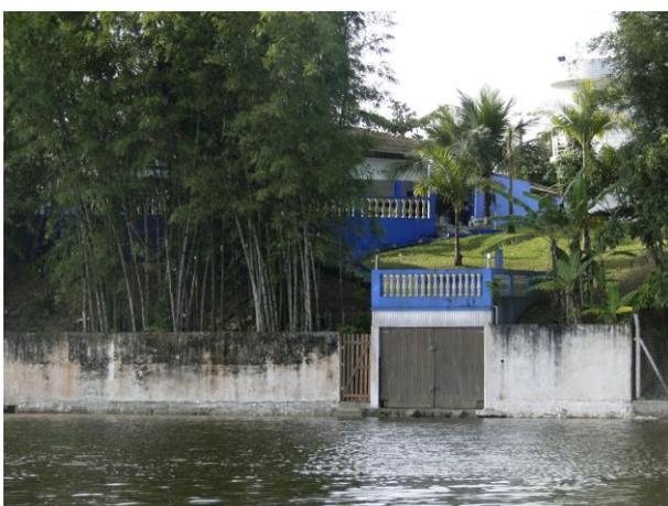
Figura 74. Muro para supostamente conter a erosão e delimitar a propriedade. Fonte: Pesquisa de campo. Ano: Mai./2013.
