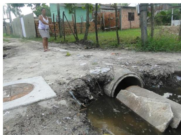
Figura 59. Manilha da drenagem desaguando em área de manguezal. Fonte: Pesquisa de campo. Ano: Fev./2015.
