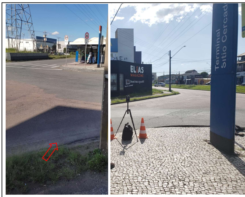
Figura 55: Sinalização horizontal inexistente ou com as demarcações fracas.
